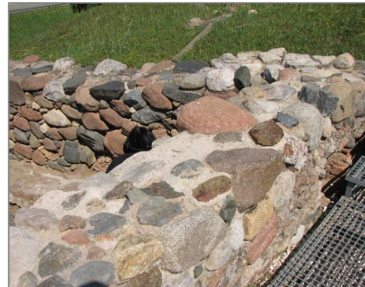
Consolidació de la testera dels murs
