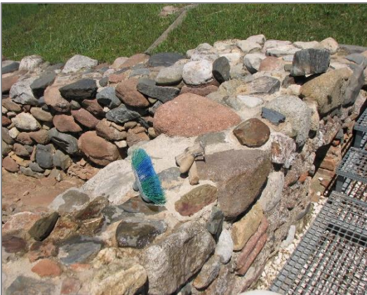
Consolidació de la testera dels murs
