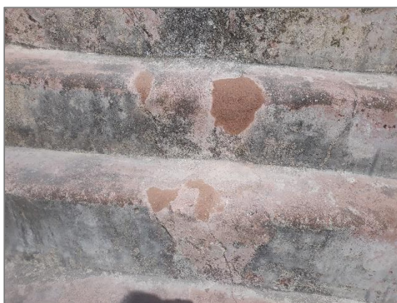
Revestiment dels graons del frigidari
