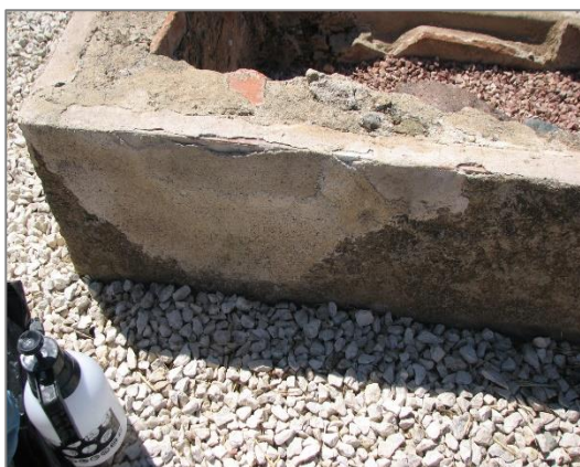
Consolidació de l'arrebossat del dipòsit de la terrassa superior
