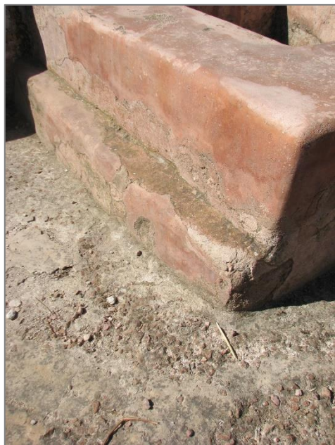
Revestiment exterior d'un dels dipòsits de l' apodyterium
