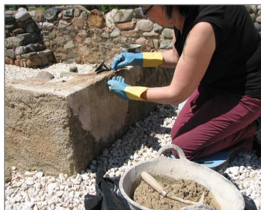
Consolidació de l'arrebossat del dipòsit de la terrassa superior
