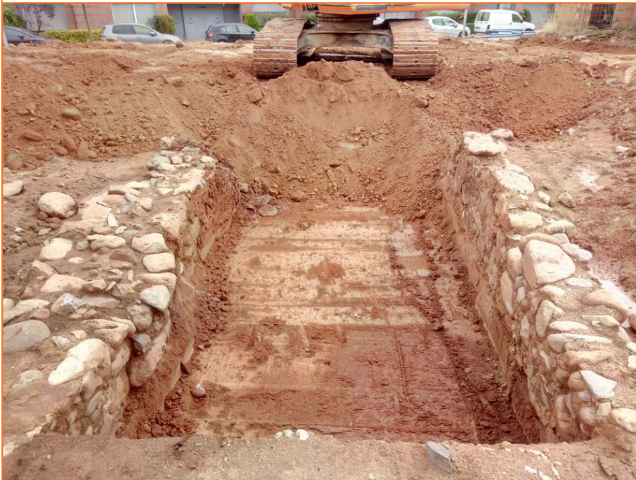
Foto 14. Buidatge i desmuntatge del camí d'accés a Can Noguera.
