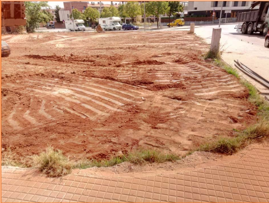
Foto 23. Fotografia final del solar després de la realització dels treballs de desmuntatge.
