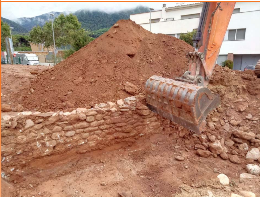
Foto 15. Desmuntatge murs camí d'accés a Can Noguera.
