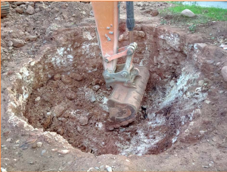
Foto 17. Procés de buidatge del forn de calç.
