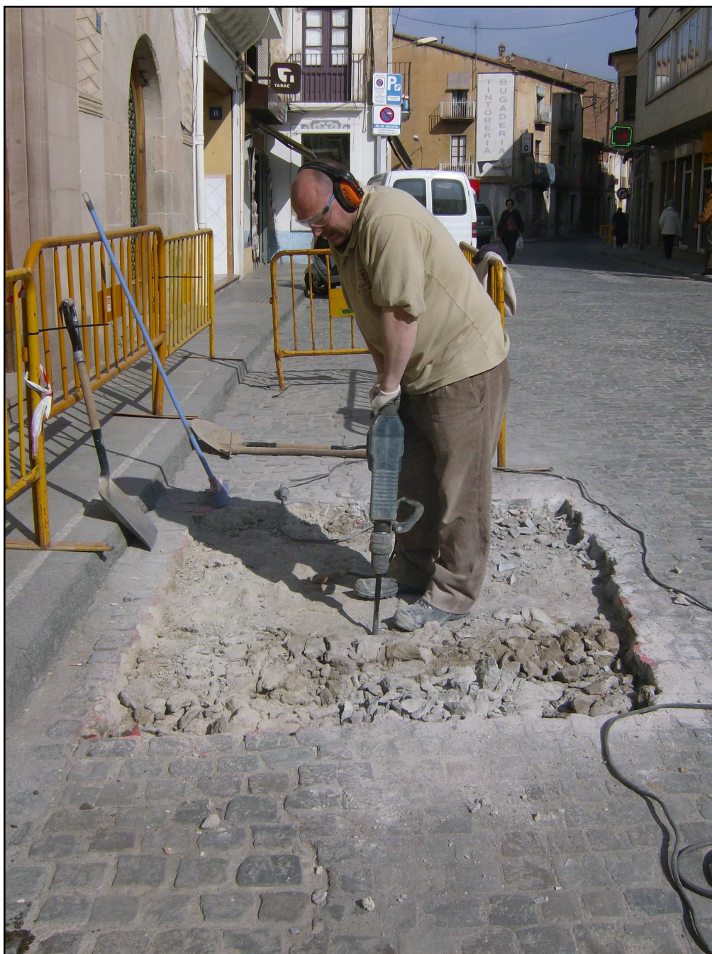
Retirada mecànica de la preparació de formigó (UE 2) del paviment de llambordes (UE 1) del carrer del Centre. À. Caixal, març del 2010. Fons Documental de l'SPAL. Diputació de Barcelona.
