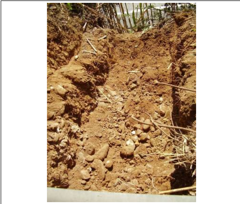
Foto 183: Àrea 3. Tasques d'excavació. Direcció est
