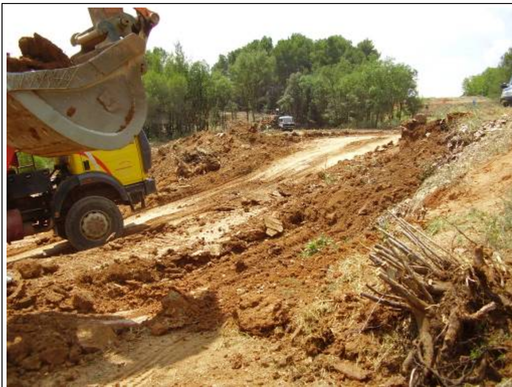
Foto 136: Àrea 2. Zona 2. Tasques d'extracció de la capa vegetal
