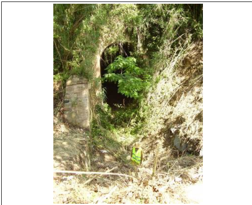
Foto 17: Àrea 2. Pont sobre el Torrent de Can Busquets
