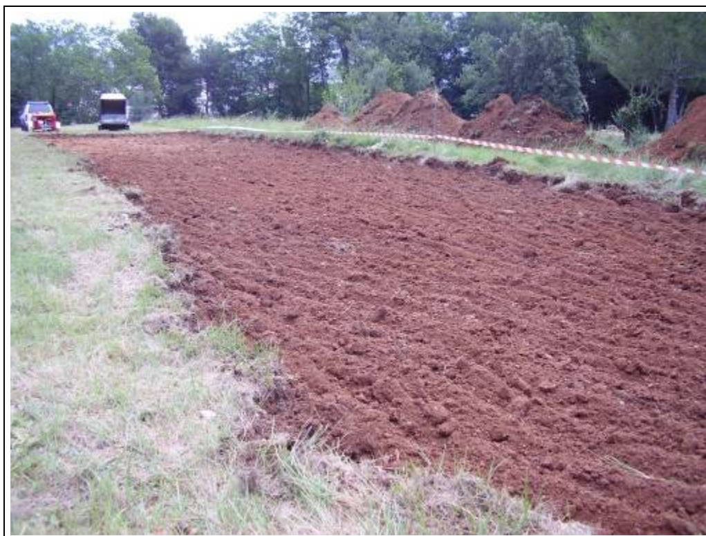
Foto 46: Àrea 2. Retirada de la capa vegetal. Direcció sud
