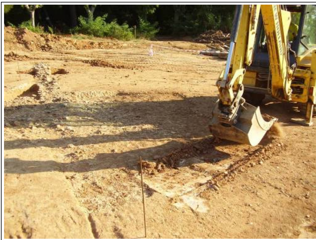
Foto 71: Zona 1. Delimitació amb màquina de la UE 1008. Direcció oest
