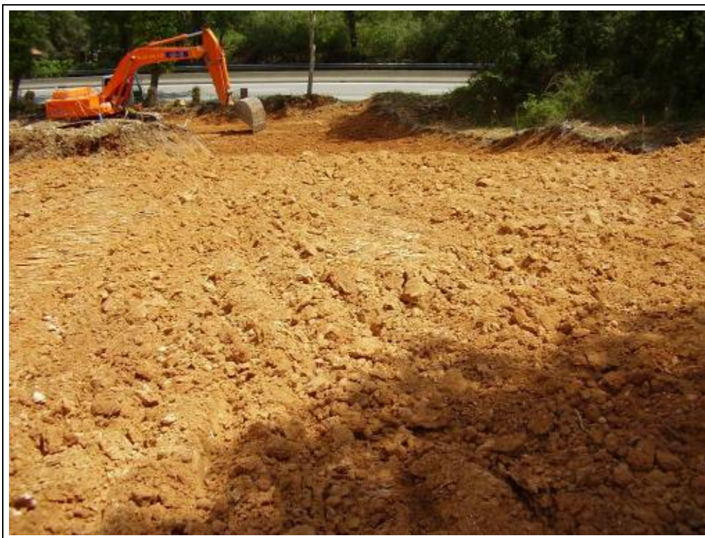
Foto 57: Àrea 2. Marge dret del torrent de Can Mas. Extracció de la capa vegetal
