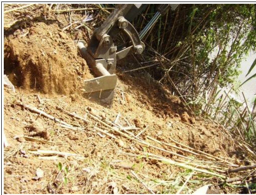
Foto 181: Àrea 3. Tasques d'excavació. Direcció nord
