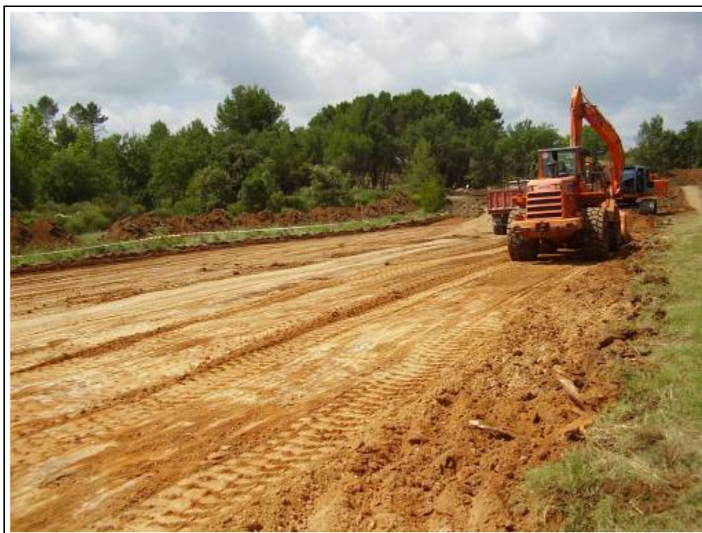
Foto 52: Àrea 2. Retirada de la capa vegetal. Direcció sud
