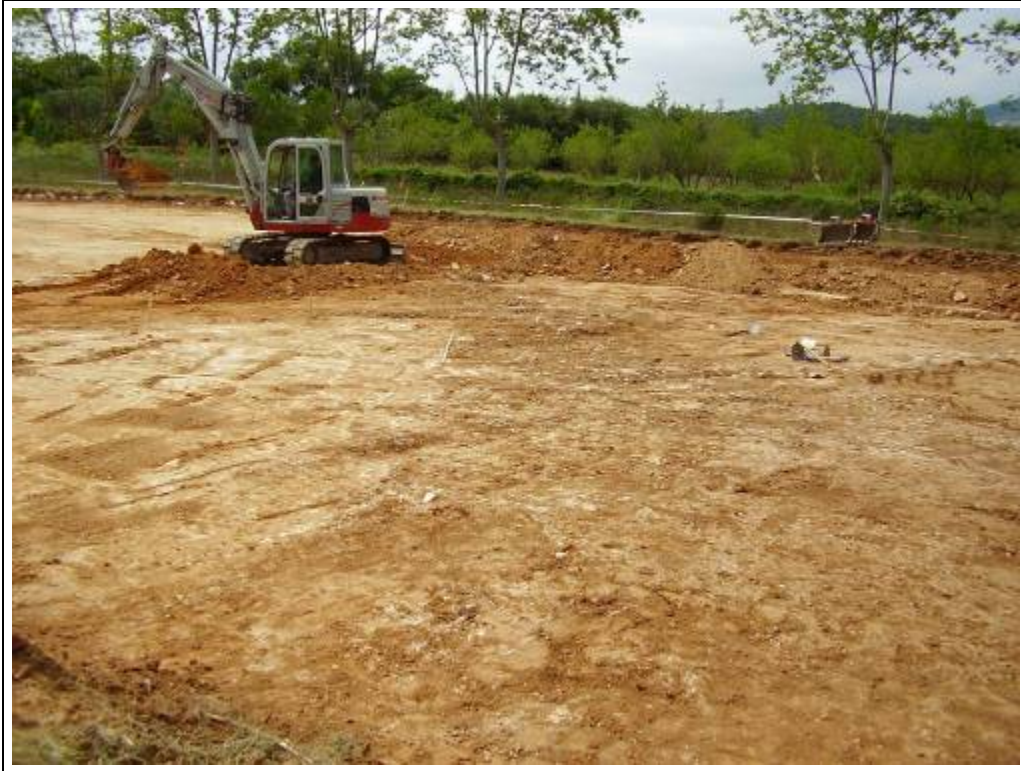
Foto 69: Zona 1. Delimitació amb màquina de la UE 1008. Direcció oest
