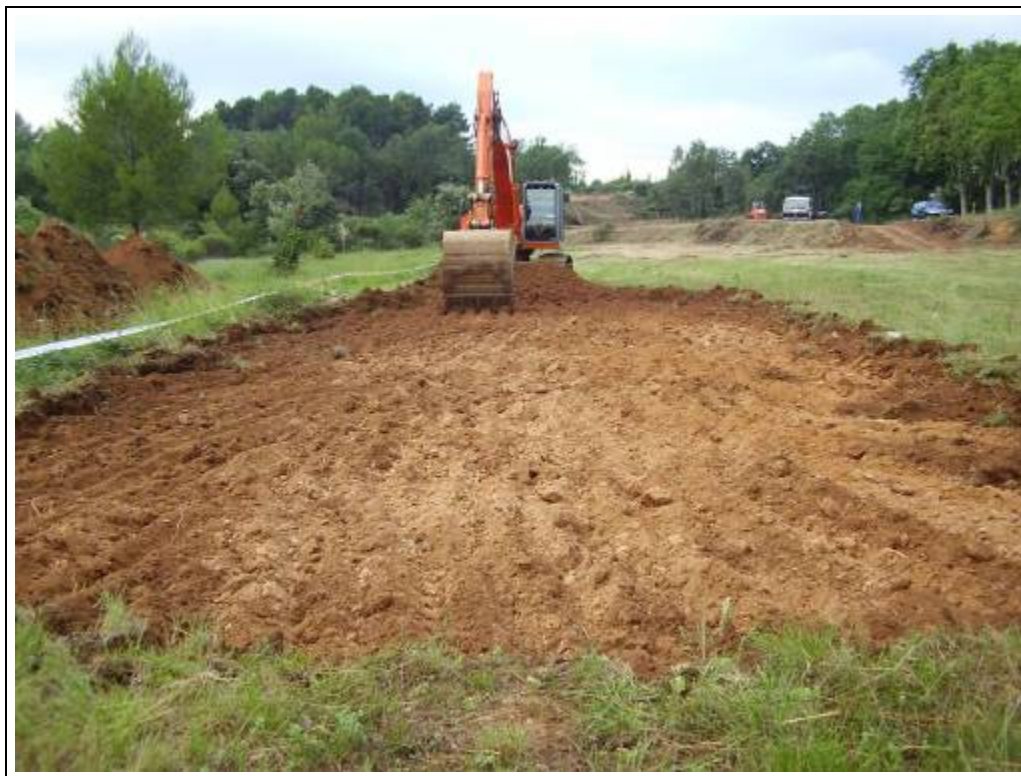
Foto 45: Àrea 2. Retirada de la capa vegetal. Direcció sud
