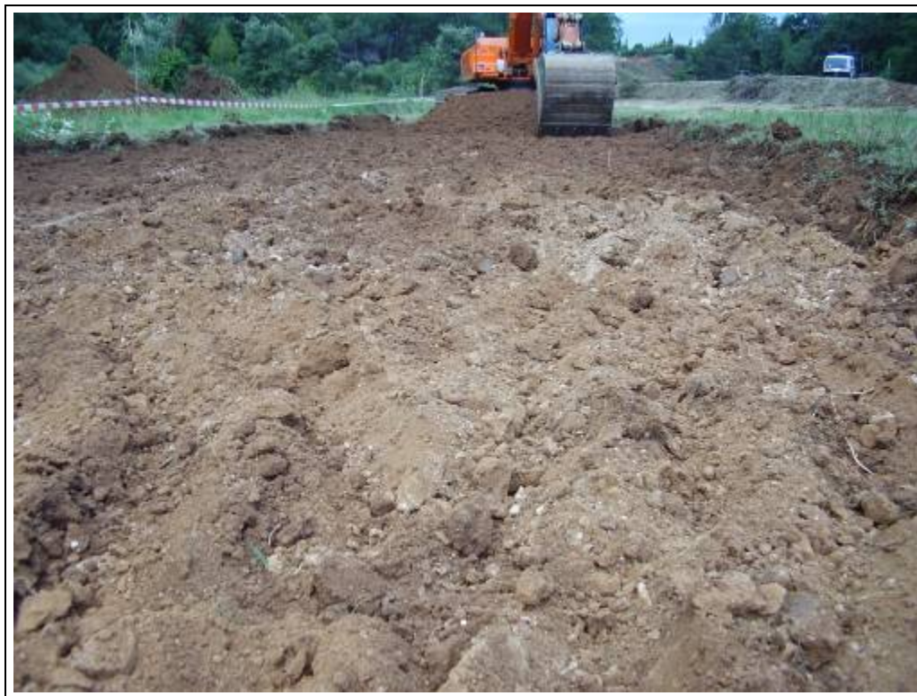
Foto 44: Àrea 2. Detall del rebaix de la capa vegetal
