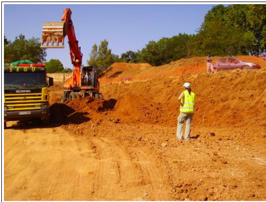
Foto 163: Zona 2. Control visual del rebaix mecànic
