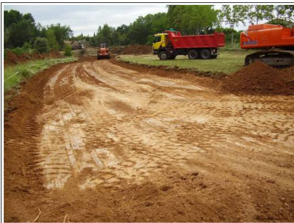
Foto 50: Àrea 2. Retirada de la capa vegetal. Direcció sud
