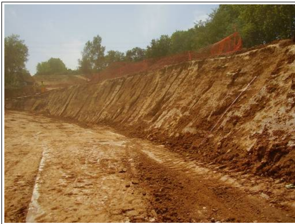
Foto 173: Zona 2. Vista general del perfil O. Final del rebaix mecànic
