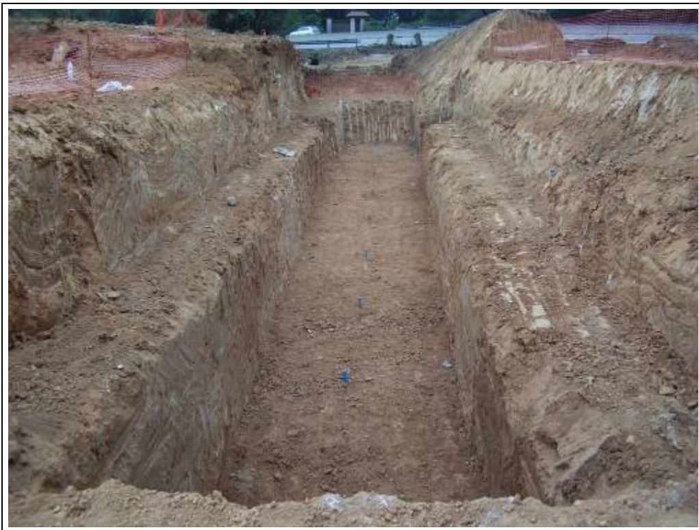
Foto 62: Àrea 2. Rebaixos a la llera del torrent de Can Mas. Direcció est
