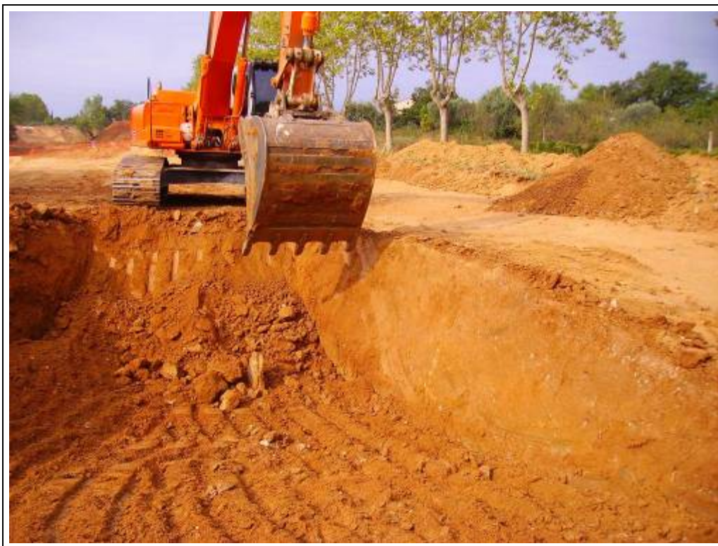
Foto 133: Zona 1. Realització del sondatge 3
