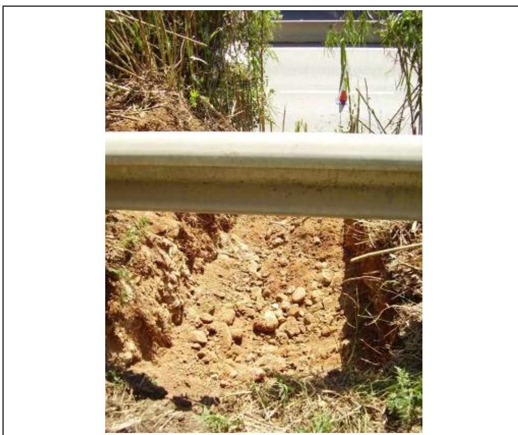
Foto 182: Àrea 3. Tasques d'excavació. Direcció est
