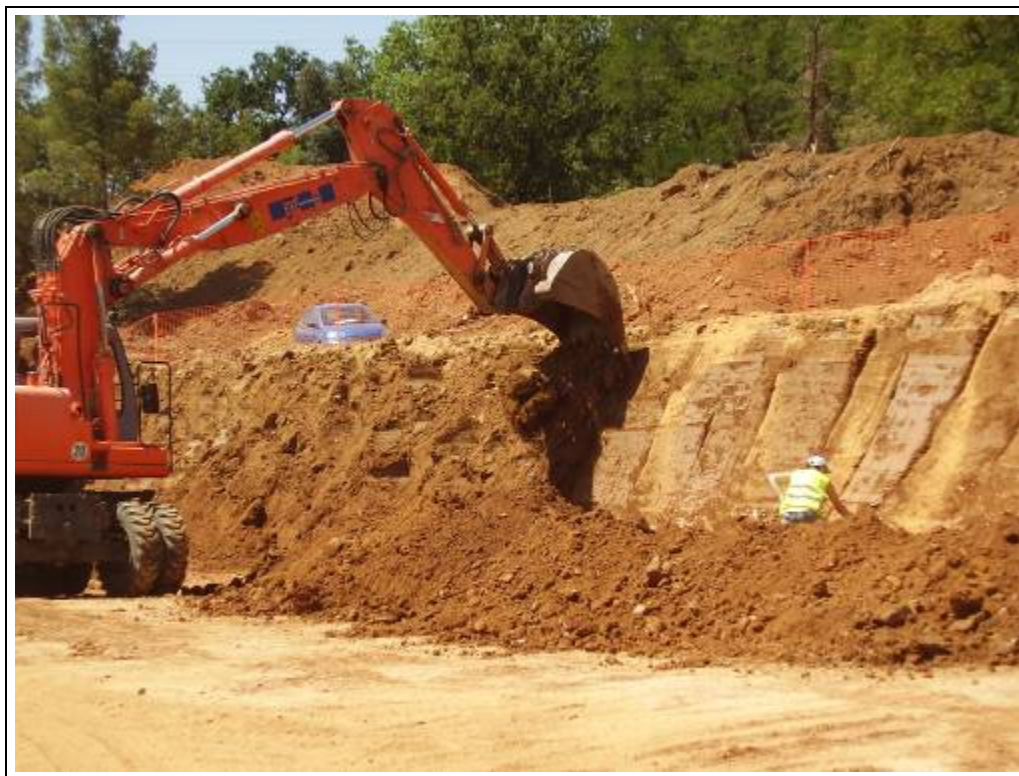
Foto 167: Zona 2. Inspecció dels perfils
