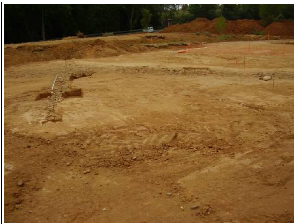
Foto 129: Zona 1. General de l'àrea excavada. Direcció E
