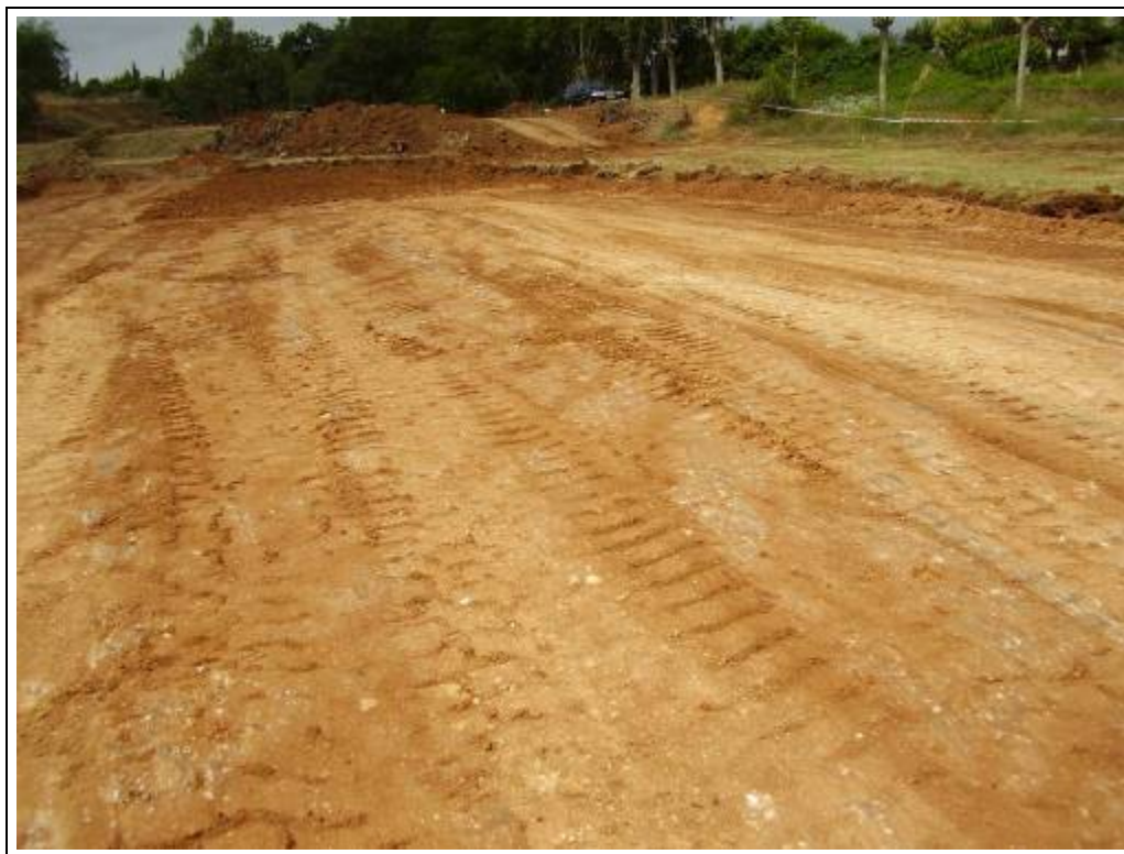
Foto 51: Àrea 2. Retirada de la capa vegetal. Direcció sud
