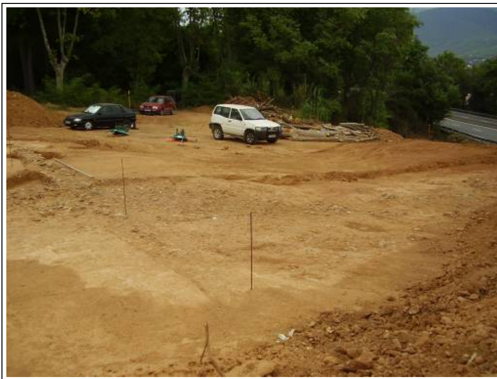
Foto 127: Zona 1. Àrea d'excavació en direcció N
