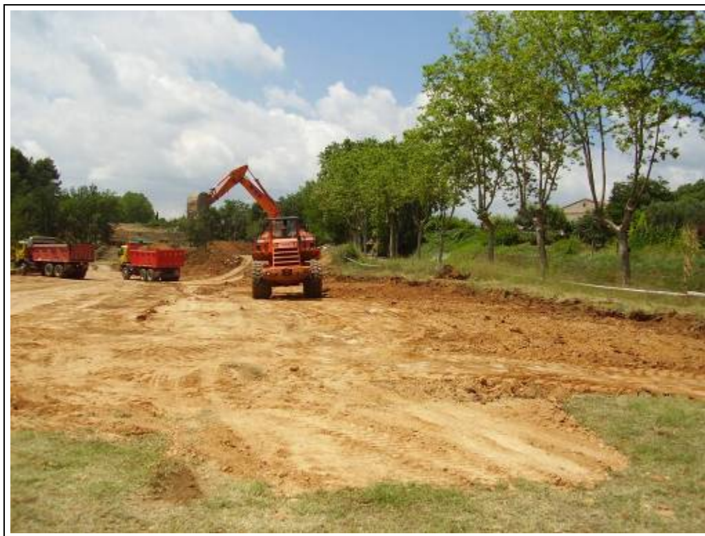
Foto 53: Àrea 2. Retirada de la capa vegetal. Direcció sud
