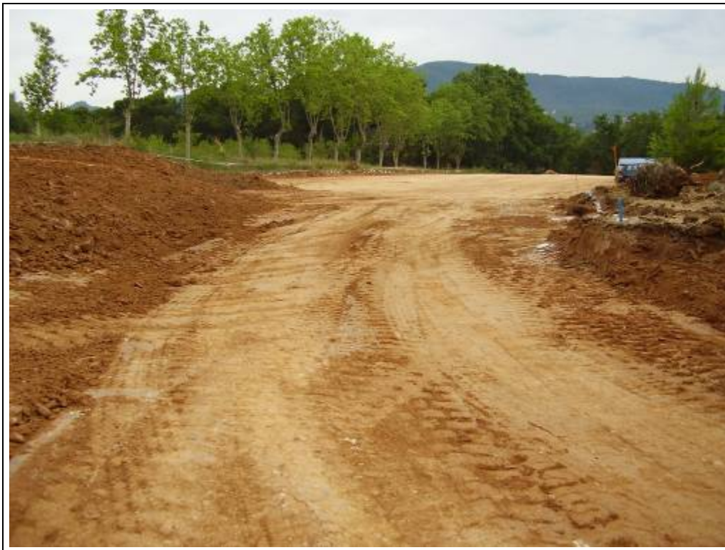
Foto 137: Àrea 2. Zona 2. Tasques d'extracció de la capa vegetal
