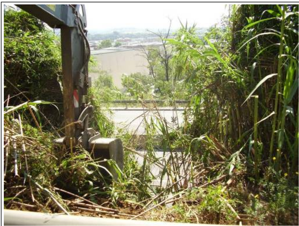
Foto 180: Àrea 3. Tasques d'excavació. Direcció est
