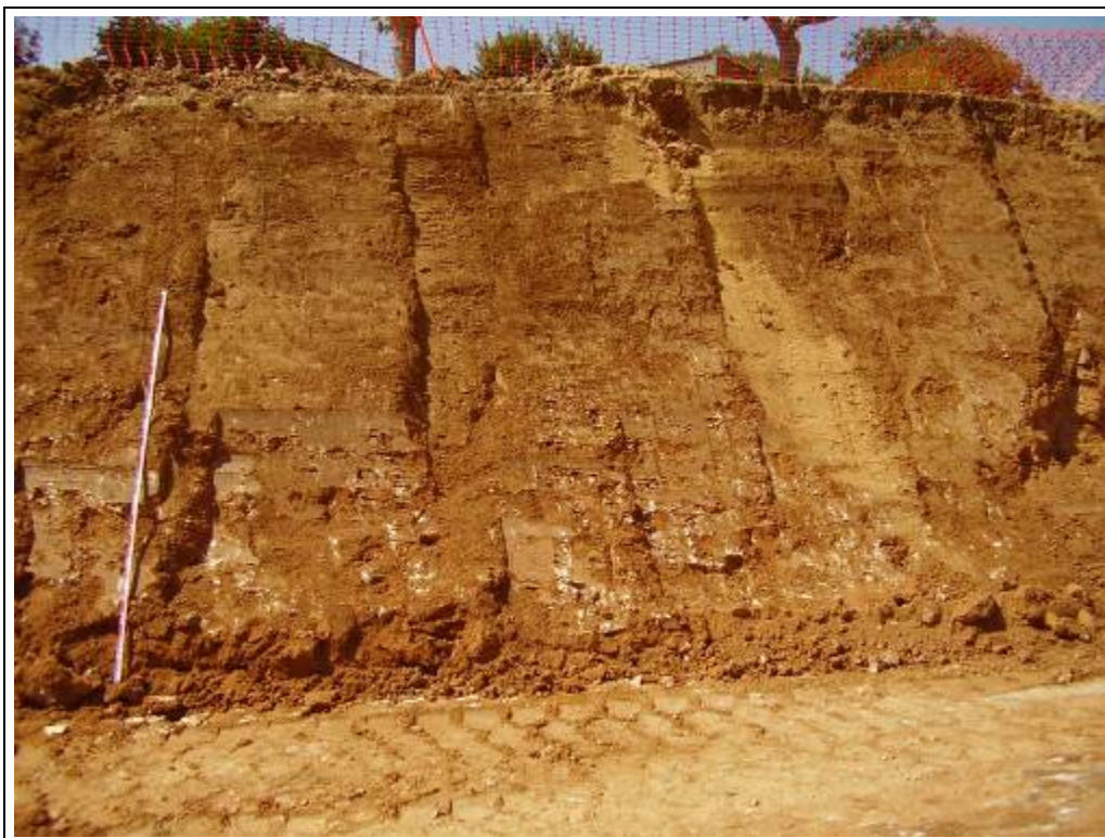
Foto 172: Zona 2. Vista general del perfil O
