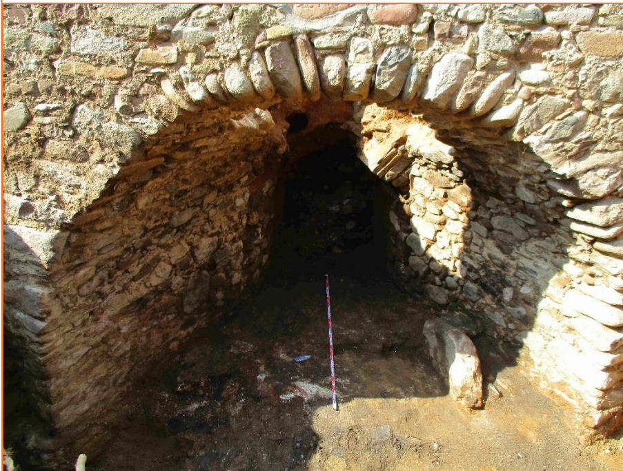
Foto 4. Vista general del passadís a nivell del paviment UE 13. Esquerra mur UE 10, dreta mur UE 11, al fons restes de l'arcada de pedra de la boca del forn UE 12. Any 2018.
