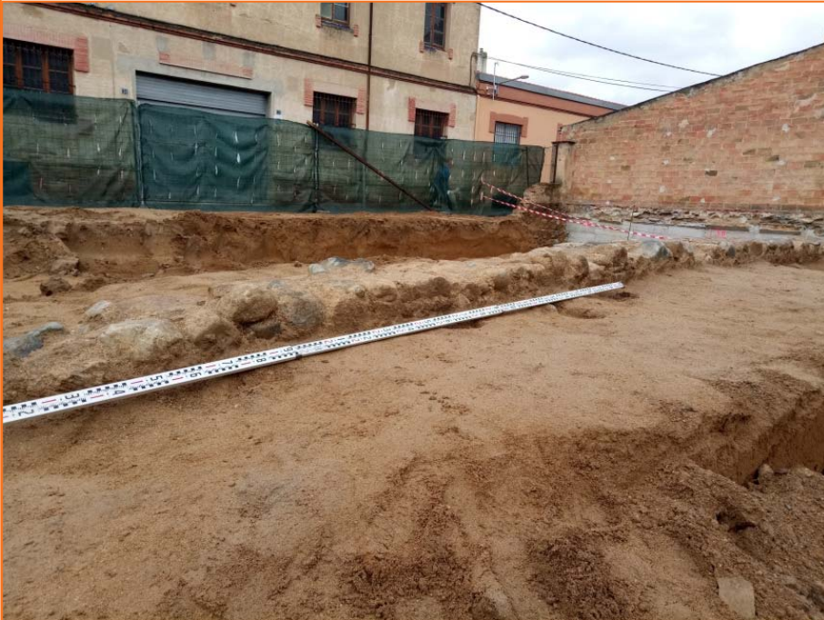
Foto 5. Vista de l'alçat del mur UE 5.
