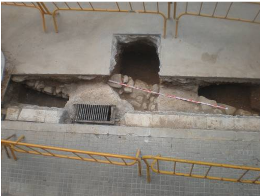
Foto 16: Mur UE 6. Final de la intervenció
