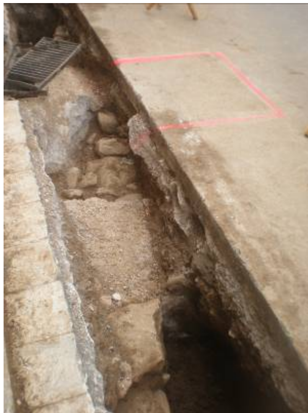
Foto 12: Localització de la zona a ampliar
