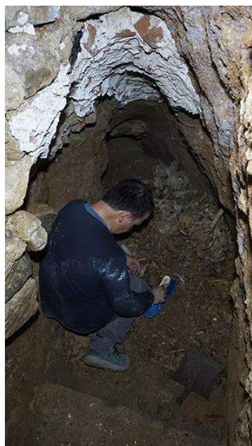
Vista dels treballs d'excavació i documentació i els treballs d'escanejament làser de la galeria subterrània.
