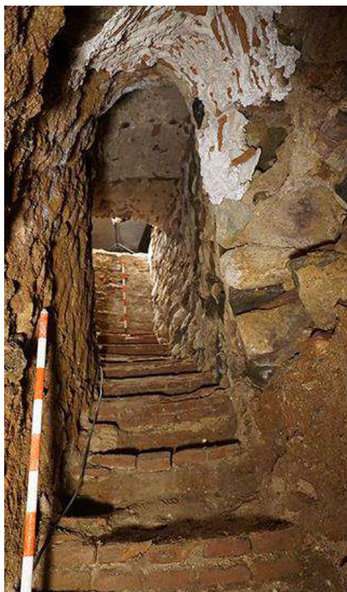
Vistes de l'interior de la galeria subterrània. S'observa les parets del primer tram, que han estat revestides amb una estructura de pedra i morter, així com els graons, fets de maó massís i morter de calç.
