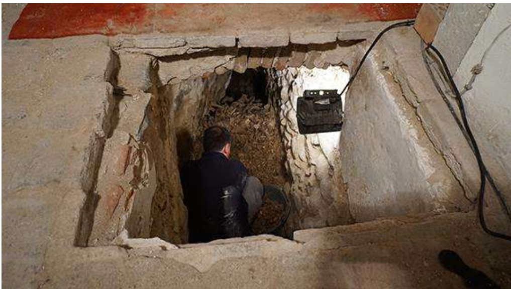
Vistes dels treballs d'excavació de la galeria subterrània.
