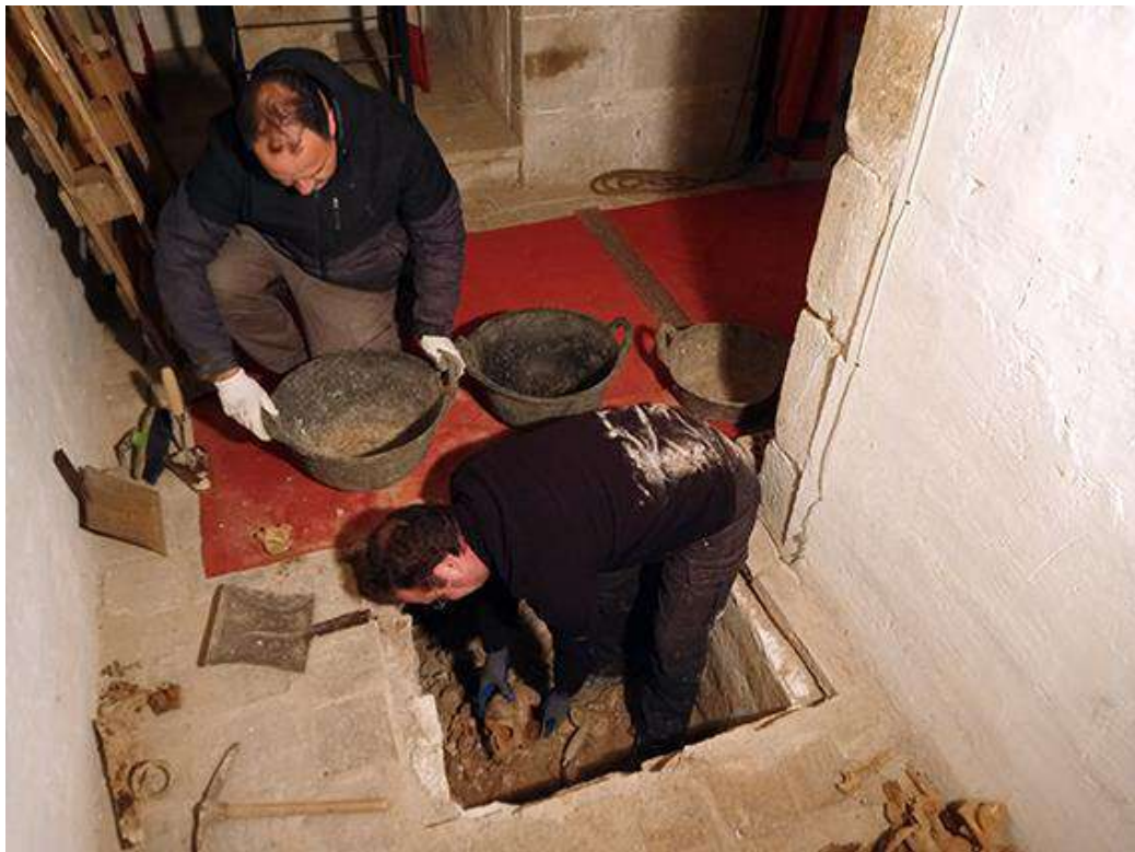
Vista de situació de la galeria subterrània localitzada a la capçalera de l'església, darrere l'altar.
