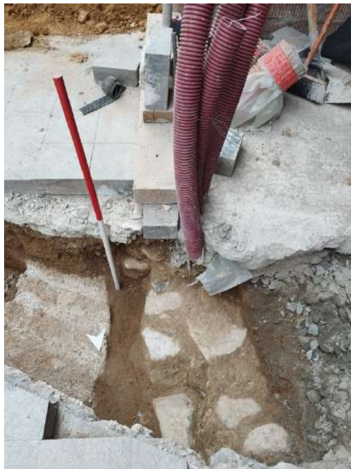
4.Vista general nord del mur UE 105.
