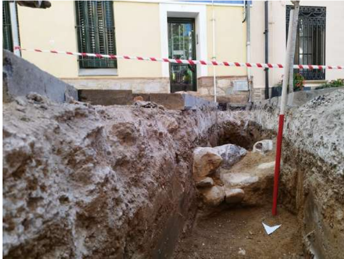
7. Vista de l'alçat nord del mur 110.
