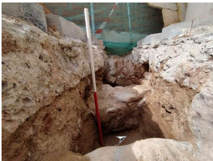
2.Vista de l'alçat est del mur UE 103.
