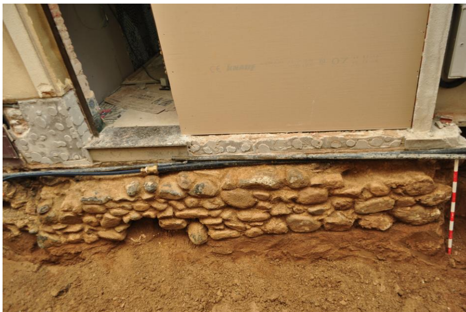
Detall de la u.e. 58, davant de la casa n° 24 (segon edifici).
