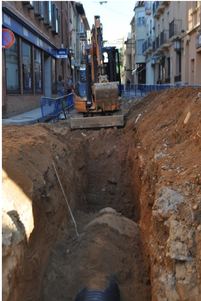
Imatge de la màquina realitzant la rasa central del carrer
