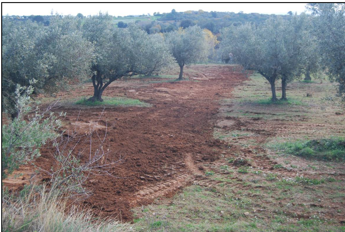
Fotografia núm. 55: Cobertura de les rases
