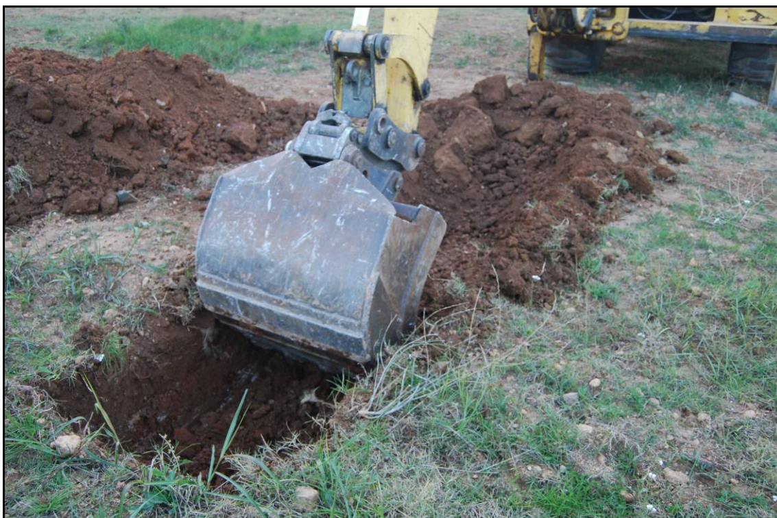
Fotografia núm. 17: Obertura de la rasa 3000
