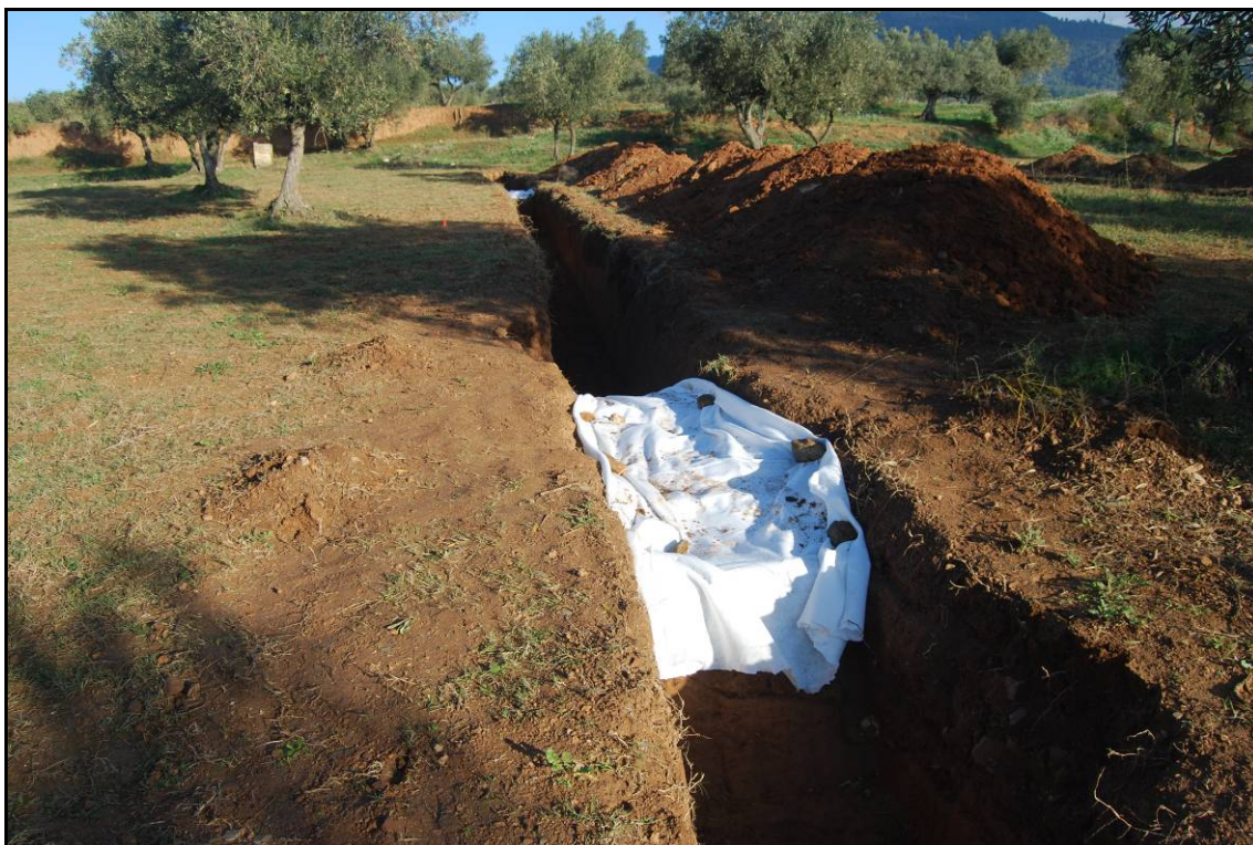
Fotografia núm. 45: Protecció de les estructures amb geotèxtil
