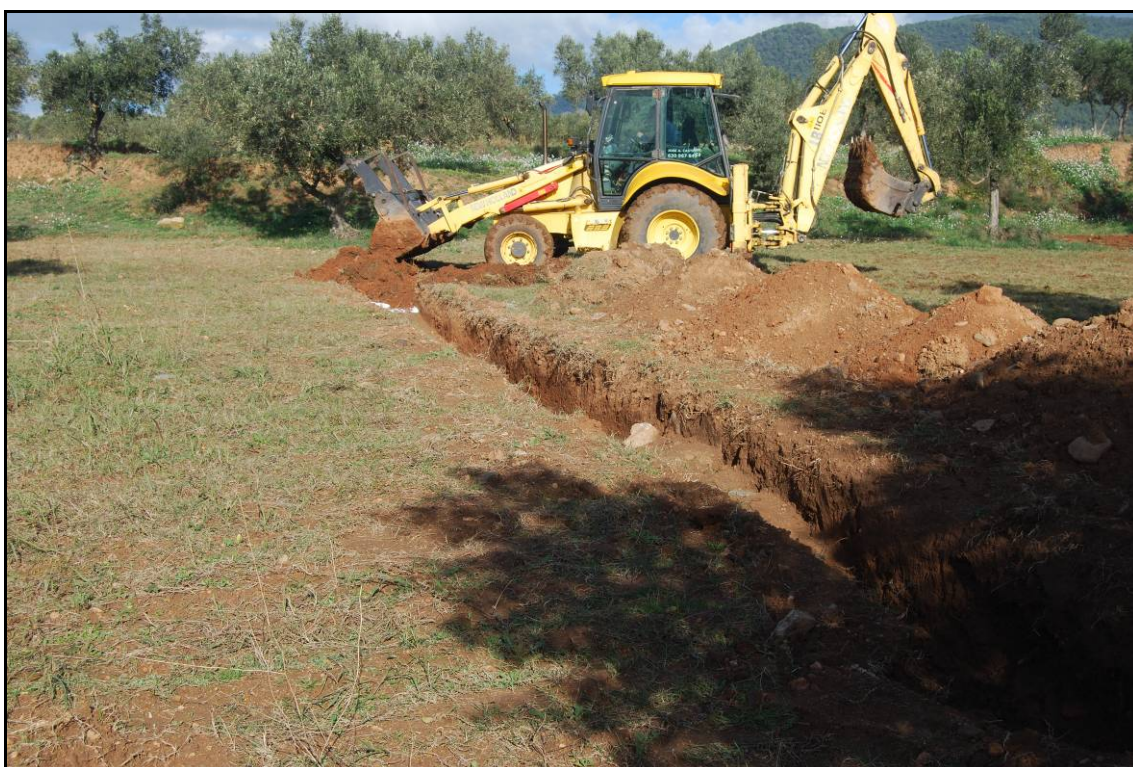
Fotografia núm. 52: Cobertura de les rases
