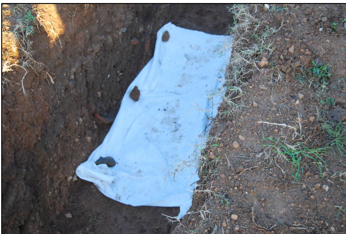
Fotografia núm. 42: Protecció de les estructures amb geotèxtil
