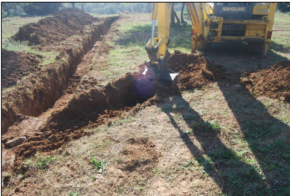
Fotografia núm. 25: Obertura de la rasa 4000
