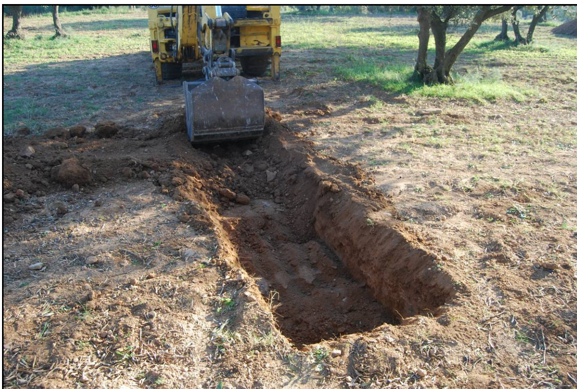
Fotografia núm. 36: Obertura de la rasa 6000
