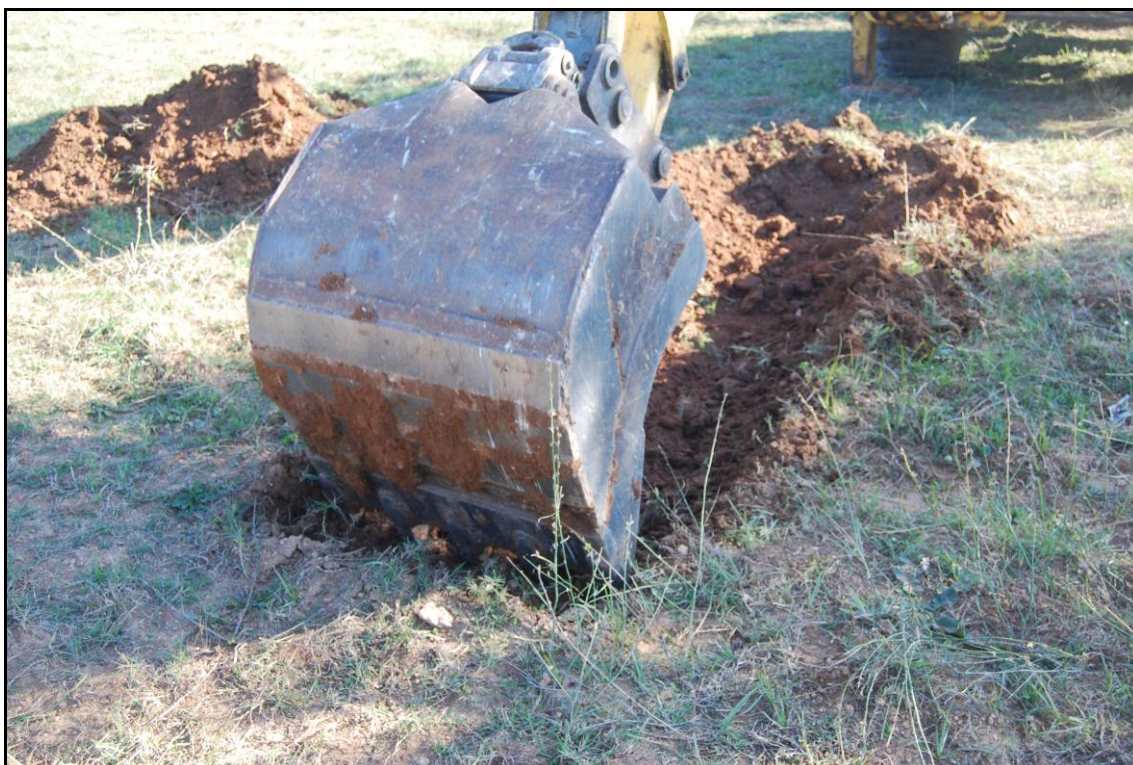
Fotografia núm. 32: Obertura de la rasa 5000
