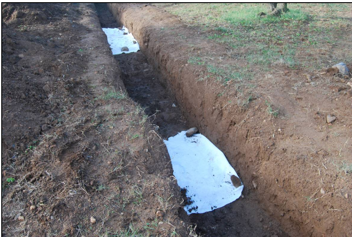
Fotografia núm. 47: Protecció de les estructures amb geotèxtil
