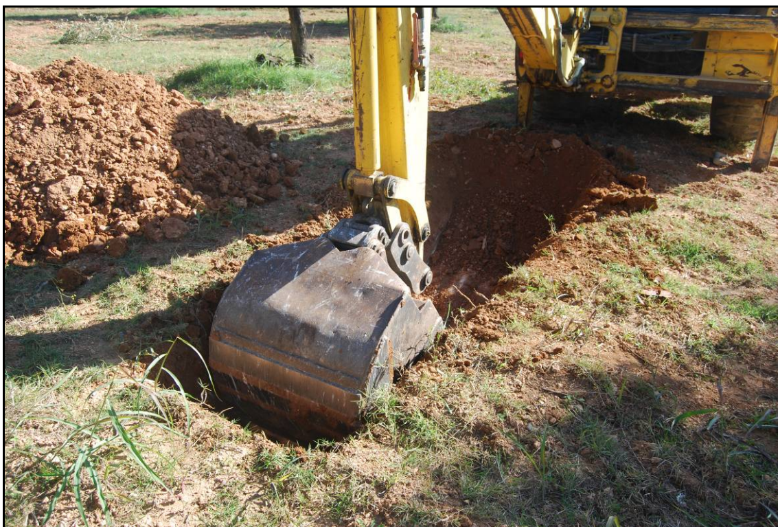
Fotografia núm. 07: Obertura de la rasa 2000
