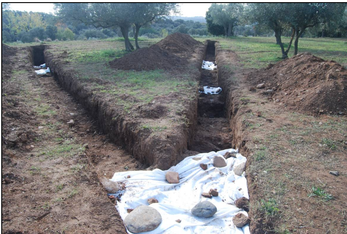
Fotografia núm. 51: Protecció de les estructures amb geotèxtil
