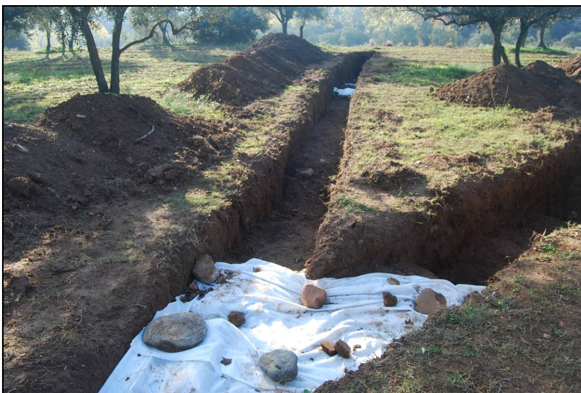
Fotografia núm. 46: Protecció de les estructures amb geotèxtil
