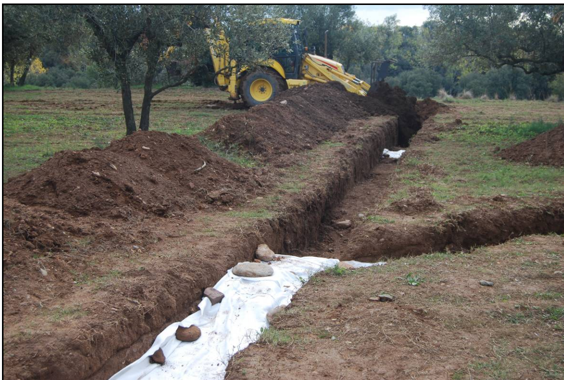
Fotografia núm. 53: Cobertura de les rases
