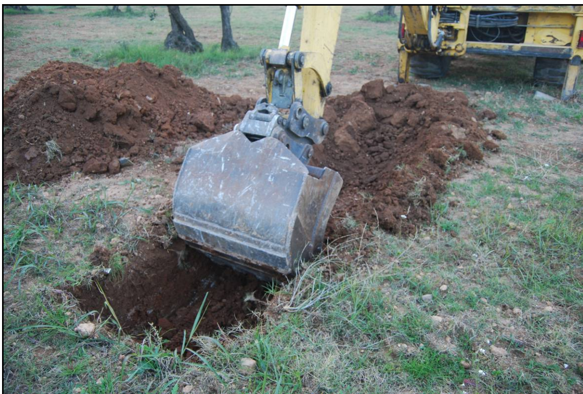
Fotografia núm. 01: Obertura de la rasa 1000
