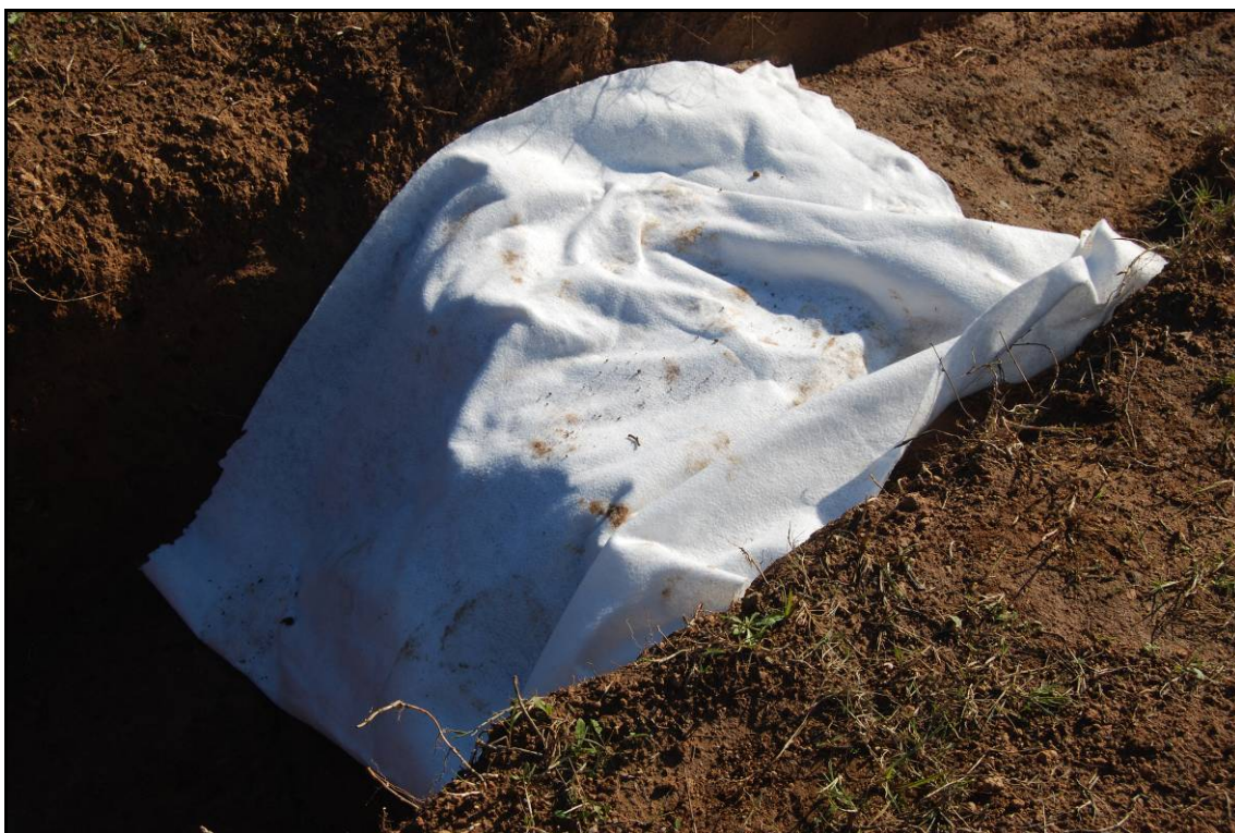
Fotografia núm. 48: Protecció de les estructures amb geotèxtil
