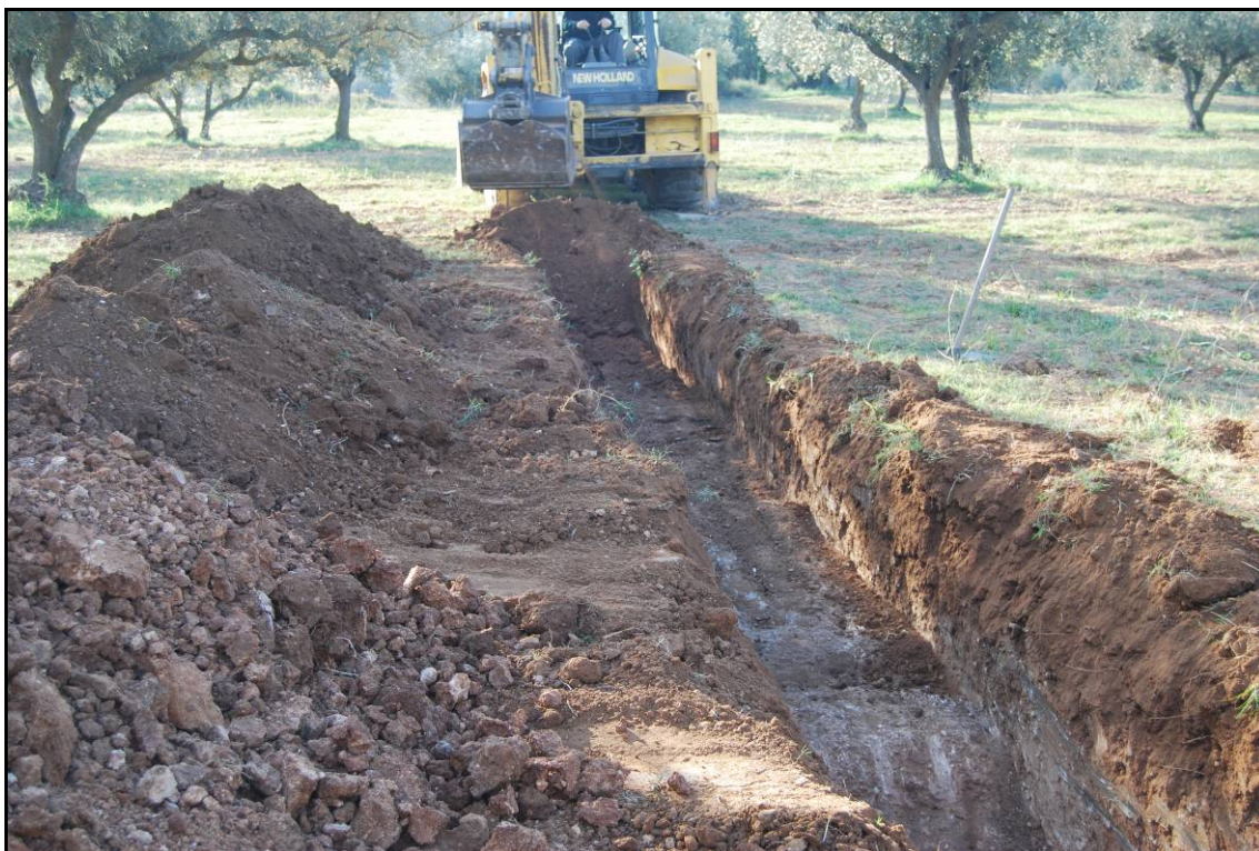
Fotografia núm. 02: Procés d'obertura de la rasa 1000
