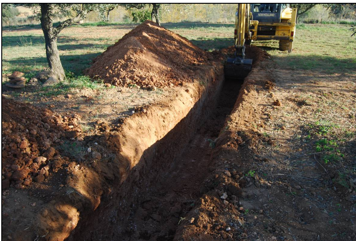
Fotografia núm. 08: Procés d'obertura de la rasa 2000
