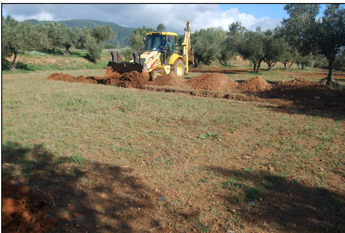
Fotografia núm. 54: Cobertura de les rases
