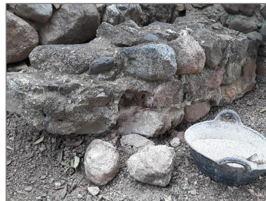
Reconstrucció del mur de la terrassa superior
