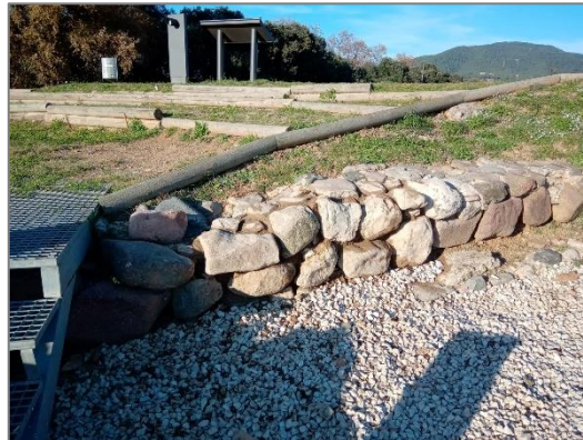
Reconstrucció del mur de la terrassa superior
