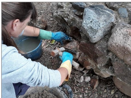
Consolidació d'elements despresos dels murs
