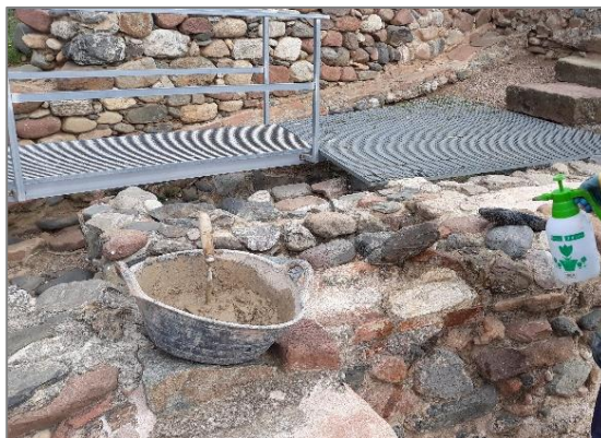
Reconstrucció del mur de la terrassa superior
