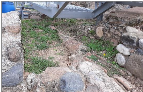
Canalització propera a la claveguera
