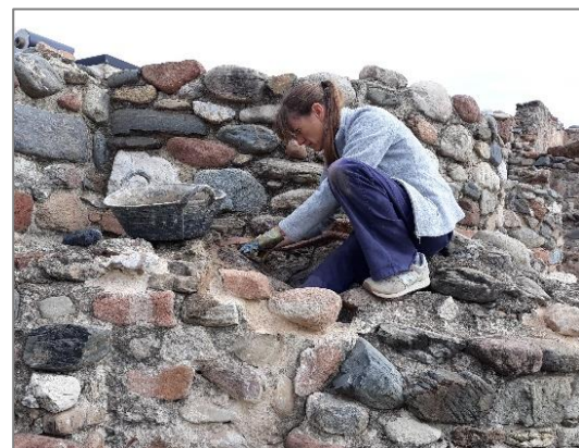
Consolidació d'elements despresos dels murs
