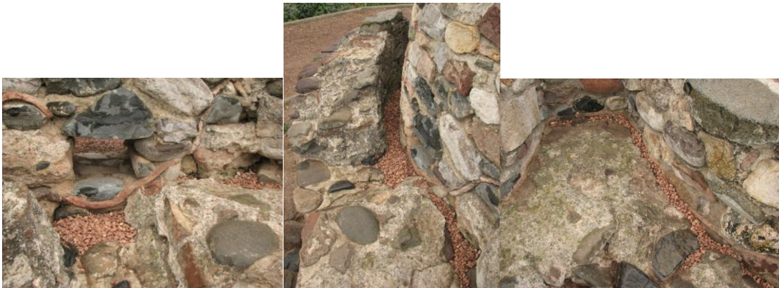
Espais reomplerts amb marmolina després de ser netejats per evitar acumulacions de terra
