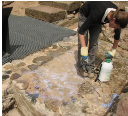
Consolidació del paviment
