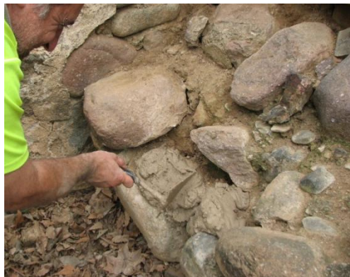
Fixació dels elements petris del mur
