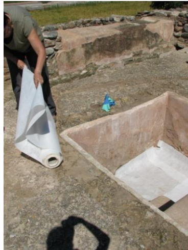
Col·locació del geotèxtil a les piscines, dipòsits i canalitzacions
