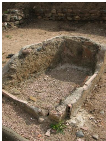
Estat inicial del dipòsit
