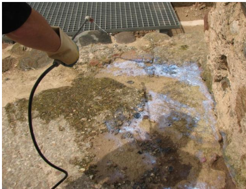
Consolidació del paviment
