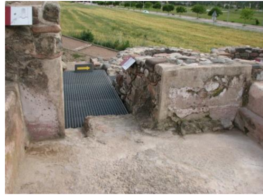
Neteja dels paviments disgregats
