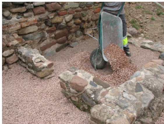
Procés de distribució de la grava
