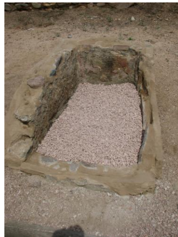
Bisellat de tota l'estructura i revestiments i col·locació de marmolina
