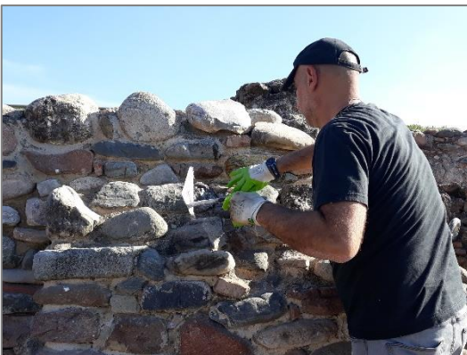
Consolidació de les testeres dels murs
