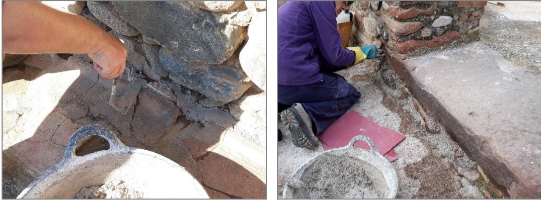
Reompliment d'espais entre paviments i murs
