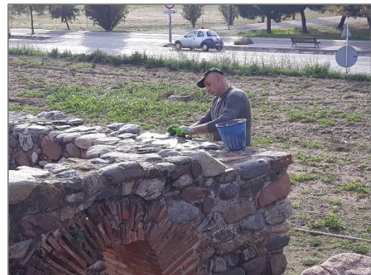
Consolidació de les testeres dels murs
