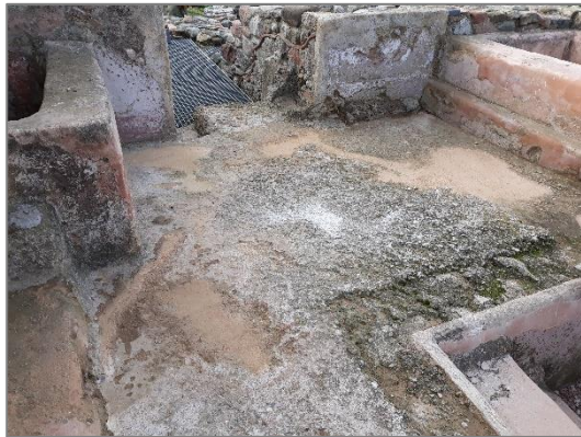
Eliminació de concrecions i briòfits dels paviments reintegrats
