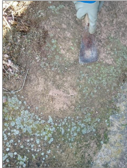
Eliminació de concrecions i briòfits dels paviments reintegrats
