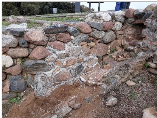
Restauració del mur de la claveguera central
