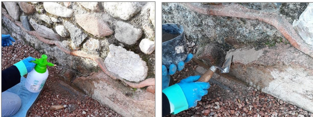
Realització de bisellats en els revestiments d' opus signinum
