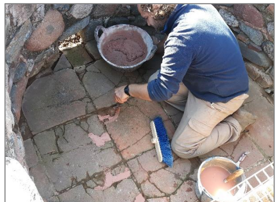
Consolidació de l'enllosat de caldarium
