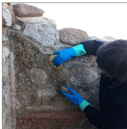
Neteja de les restes de revestiment
