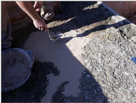
Eliminació de concrecions i briòfits dels paviments reintegrats
