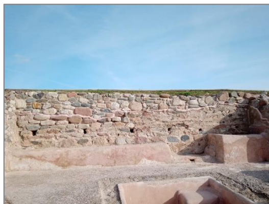
Neteja mecànica dels murs per eliminar briòfits i molsa dels morters
