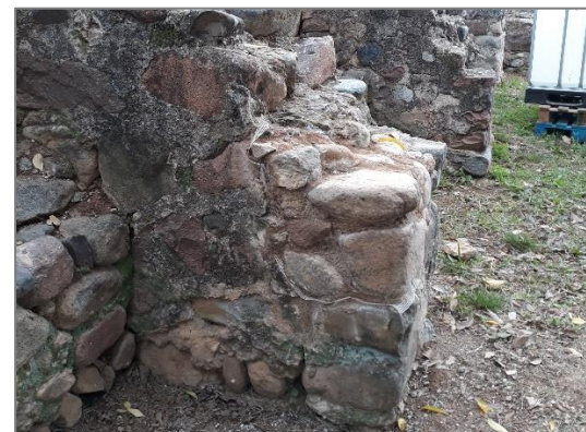
Consolidació a l'edifici dels contraforts
