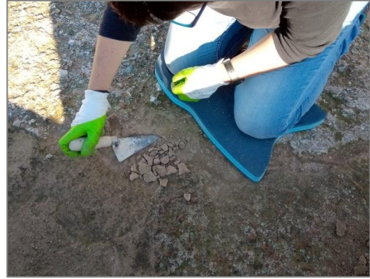
Eliminació de les reintegracions descohesionades
