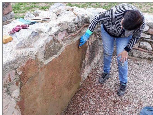
Neteja mecànica dels revestiments de signinum
