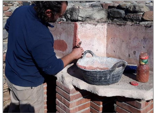
Consolidació del recobriment mural
