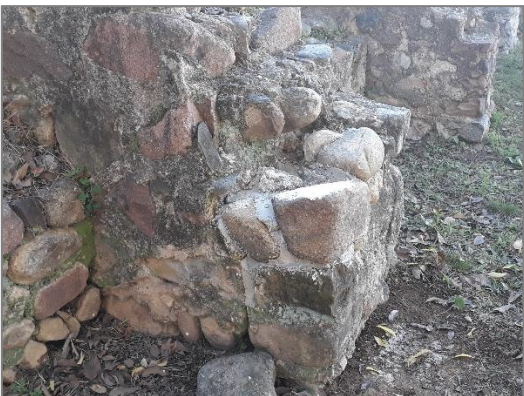
Consolidació a l'edifici dels contraforts
