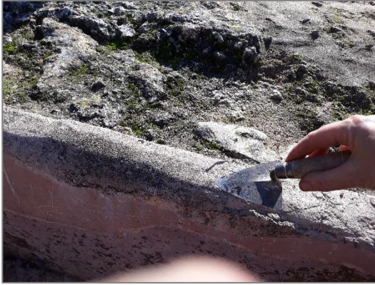
Eliminació de les reintegracions descohesionades
