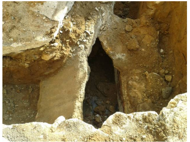
12. Desmuntatge de la coberta del rec.
