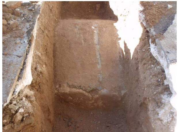
10. Volta de formigó i mur de maçoneria del rec
