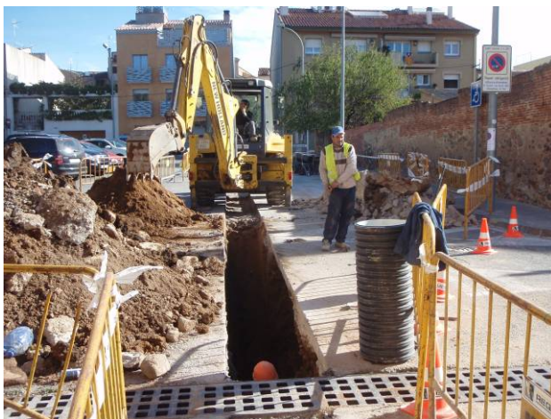
15. Treballs d'excavació de rases
