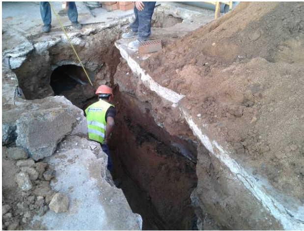
13. Desmuntatge del tram afectat del rec.
