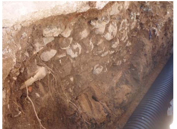
4. Detalla del mur UE 6
