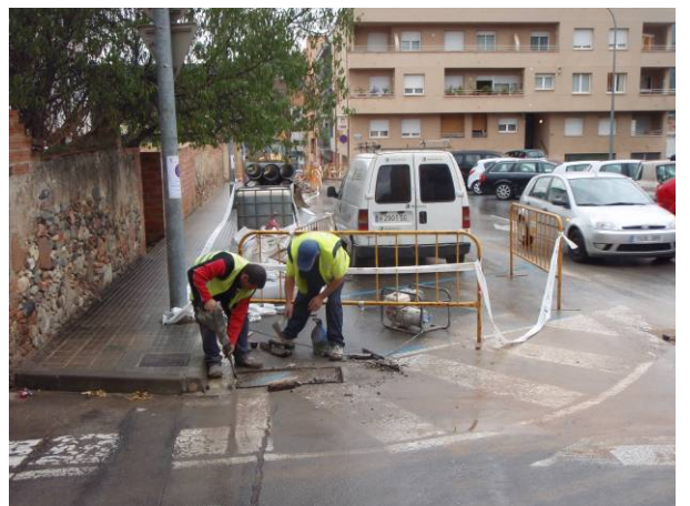
16. Treballs de l'obra
