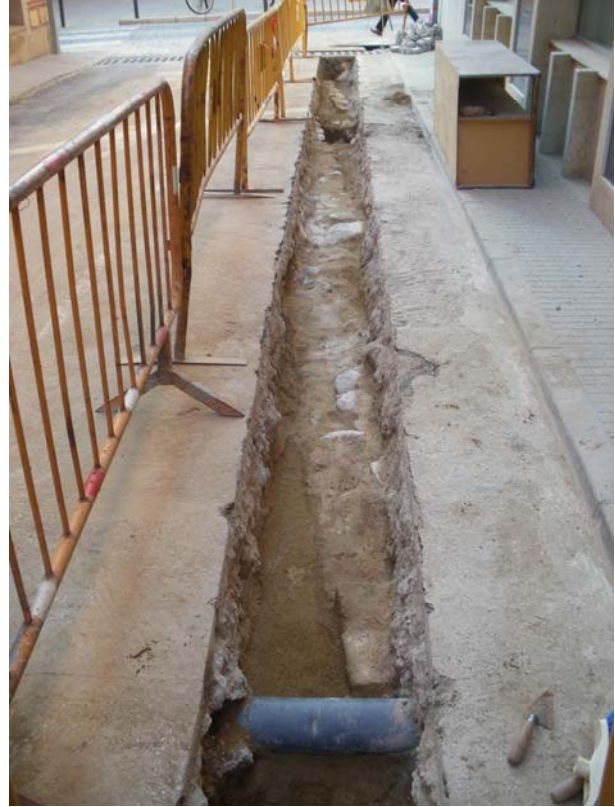
2. Vista general de la conducció d'aigua (UE 4)
