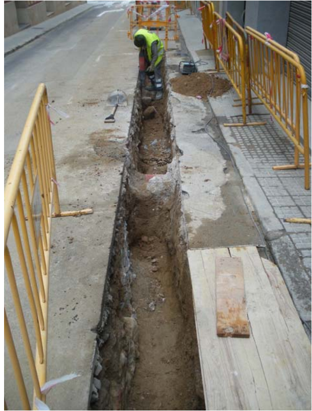
10. Treballs de desmuntatge d'estructures
