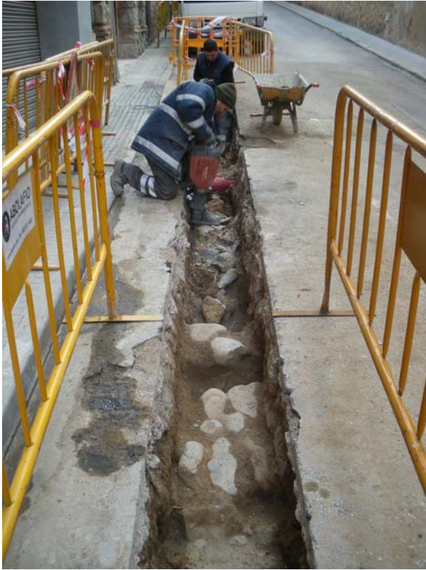
9. Treballs de desmuntatge de l'estructura indeterminada (UE 6)
