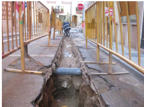
12. Treballs de desmuntatge de la conducció d'aigua (UE 4)
