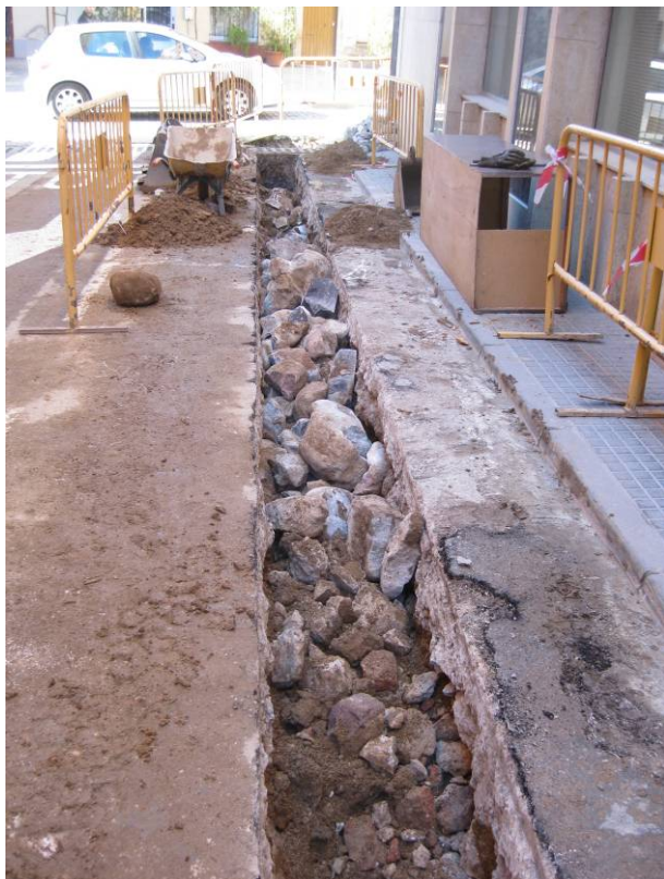
13. Conducció d'aigua desmuntada (UE 4)
