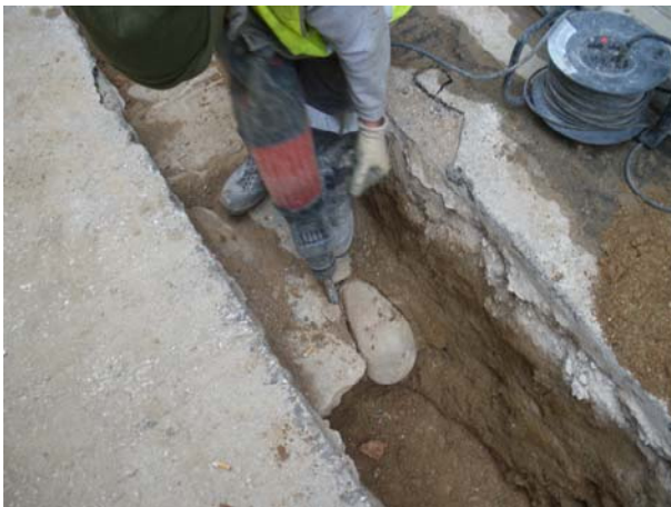
11. Desmuntatge del paviment (UE 5)
