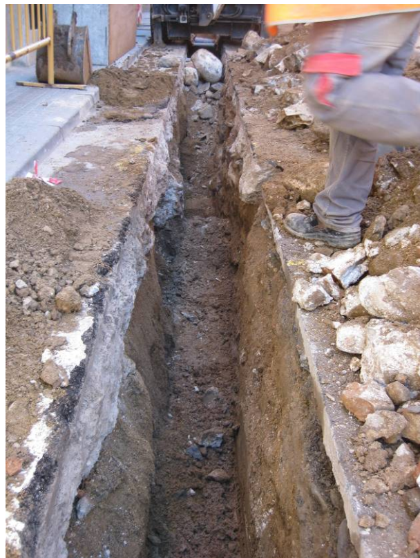
14. Finalització de l'eliminació de restes de la rasa
