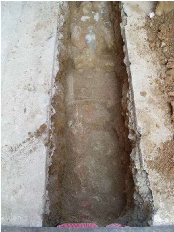
7. Estructura indeterminada (UE 5)
