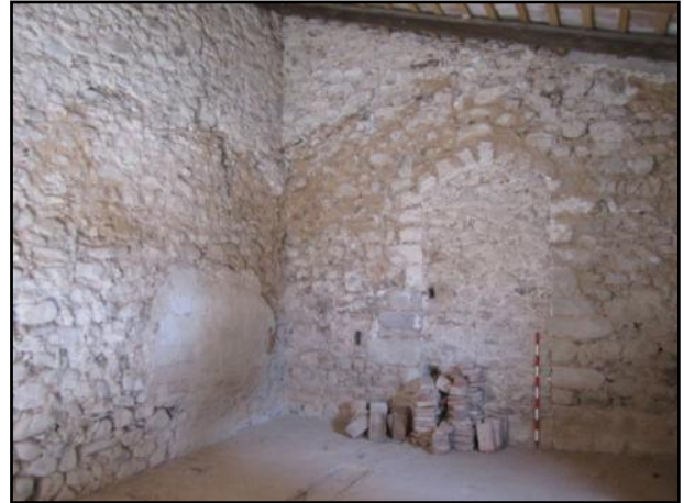
FOTO 10. Porta tapiada al mur de tramuntana de l'àmbit A2. Podem observar, al parament, que la coberta original era de dos aiguavessos
