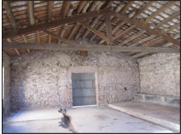
FOTO 2. Interior de l'àmbit A1 abans de començar la intervenció de control
