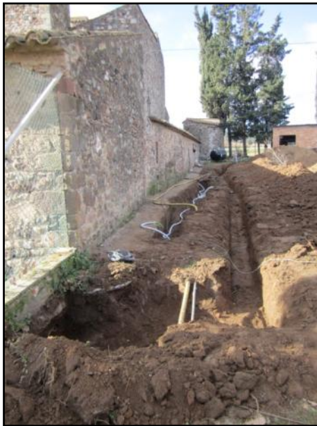
FOTO 29. Vista general de les rases R3 i R4
