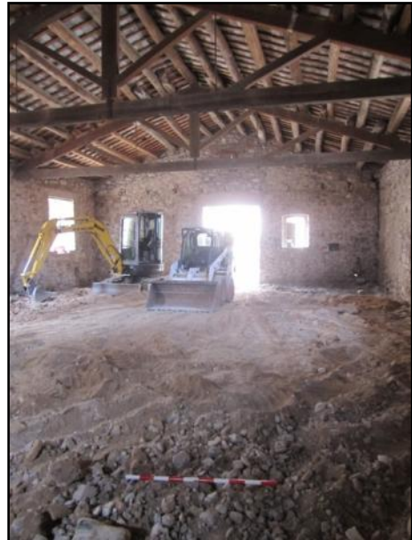
FOTO 8. Rebaix general de l'àmbit A1
