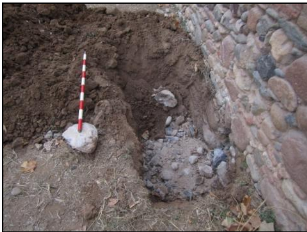
FOTO 19. Cala C2, a la façana de llevant
