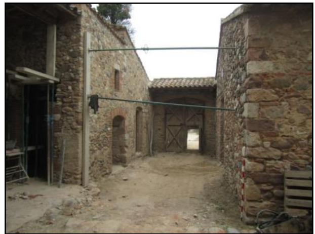
FOTO 16. Vista general del corredor que comunica la porta del barri amb l'entrada a l'edifici principal del complex. Podem apreciar que, majoritàriament, era de terra piconada
