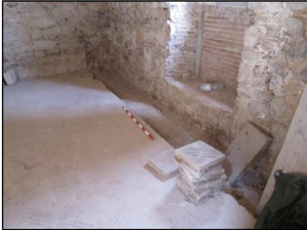
FOTO 9. Paviment de toves original de l'àmbit A2
