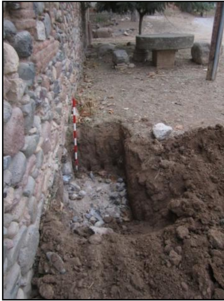
FOTO 21. En aquesta imatge podem apreciar com la profunditat de la cala C2 se situà al voltant dels 50 cm
