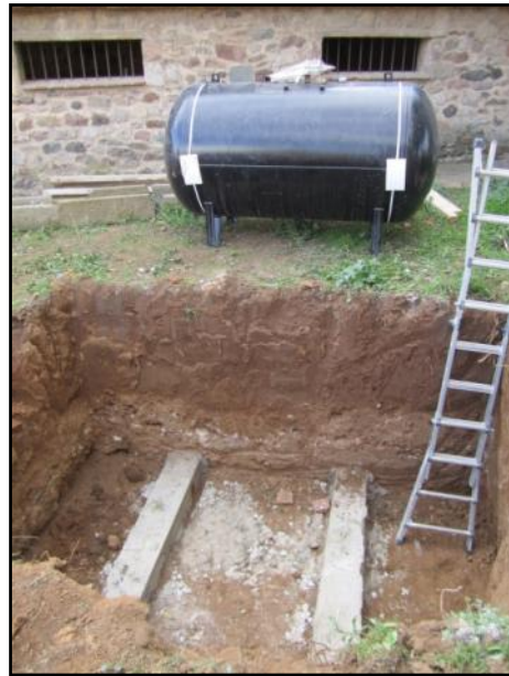
FOTO 26. Instal·lació del dipòsit de gas propà a la cala C1
