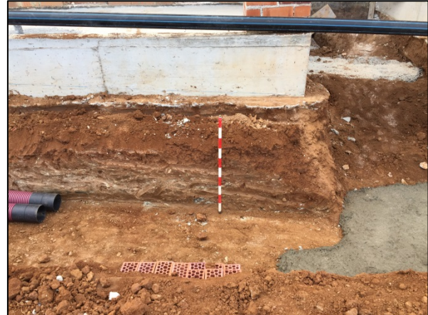
Figura 21. Detall estratigrafia rasa de serveis
