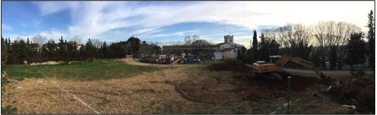
Foto 1. Panoràmica de l'estat inicial de l'excavació. Zona de l'edifici 1. Al fons la masia de Can
