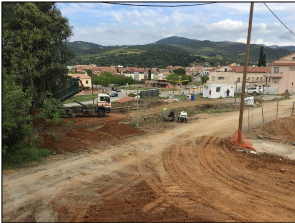
Foto 13. Estat inicial zona edifici 2 un cop desbroçat
