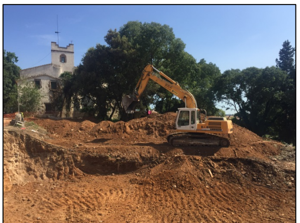
Foto 16. Inici tasques d'excavació del calaix
