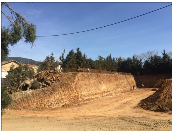
Foto 9. Estat final del control arqueològic. Edifici 1
