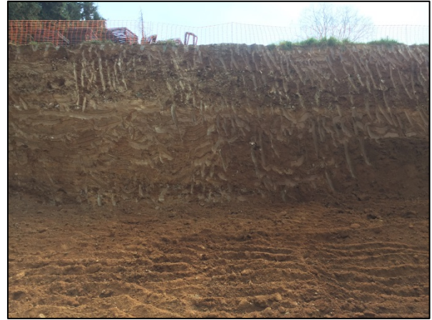
Foto 12. Estat final. Talús meridional edifici 1
