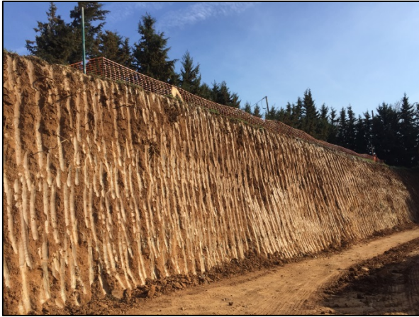
Foto 11. Estat final. Talús septentrional edifici 1
