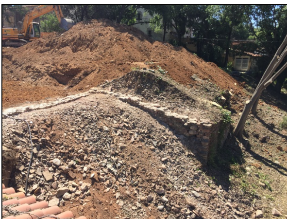
Foto 15. Vista general mur de marge UE 208, 209 i 2010
