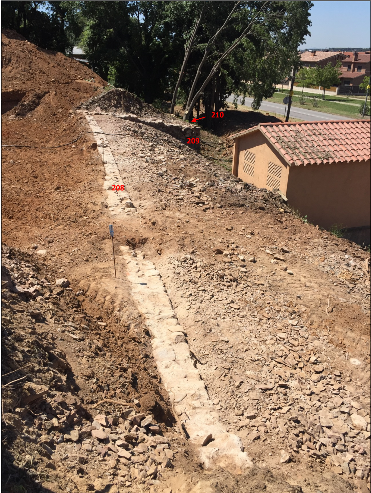
Figura 7. Vista general (cap al sud) dels murs UE 208 i 209 i 2010
