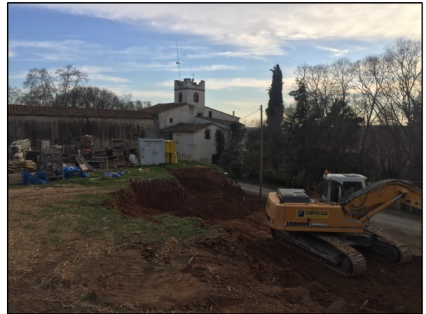
Foto 3. Inici de les tasques d'excavació. Edifici 1
