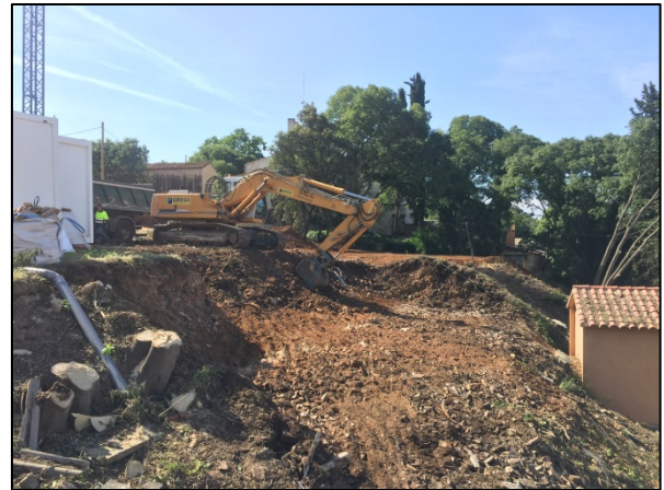
Foto 14. Inici tasques d'excavació del calaix. Edifici 2
