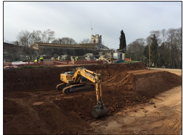
Foto 8. Tasques d'excavació. Edifici 1
