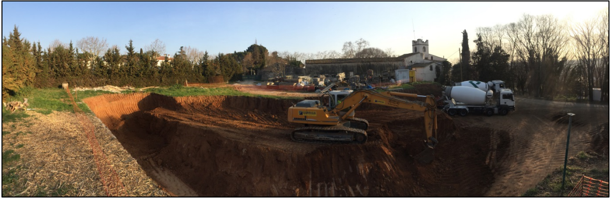
Foto 6. Panoràmica de les tasques d'excavació de l'edifici 1.
