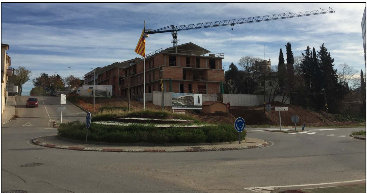
Figura 19. Estat final del costat de ponent de l'àmbit del projecte
