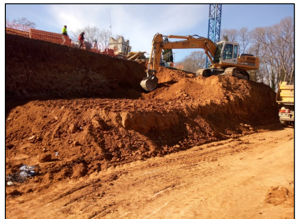
Foto 10. Darreres tasques d'excavació a l'edifici 1
