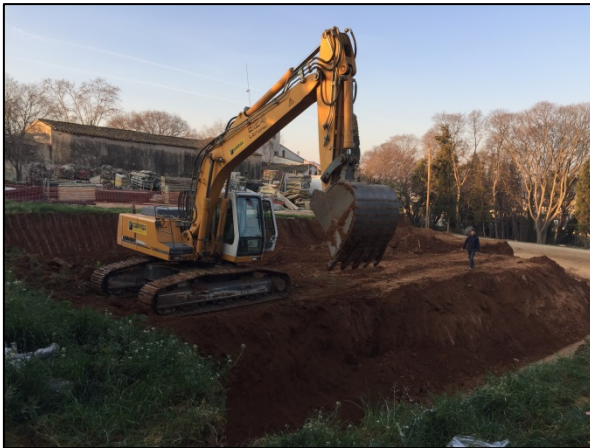
Foto 7. Tasques d'excavació. Edifici 1
