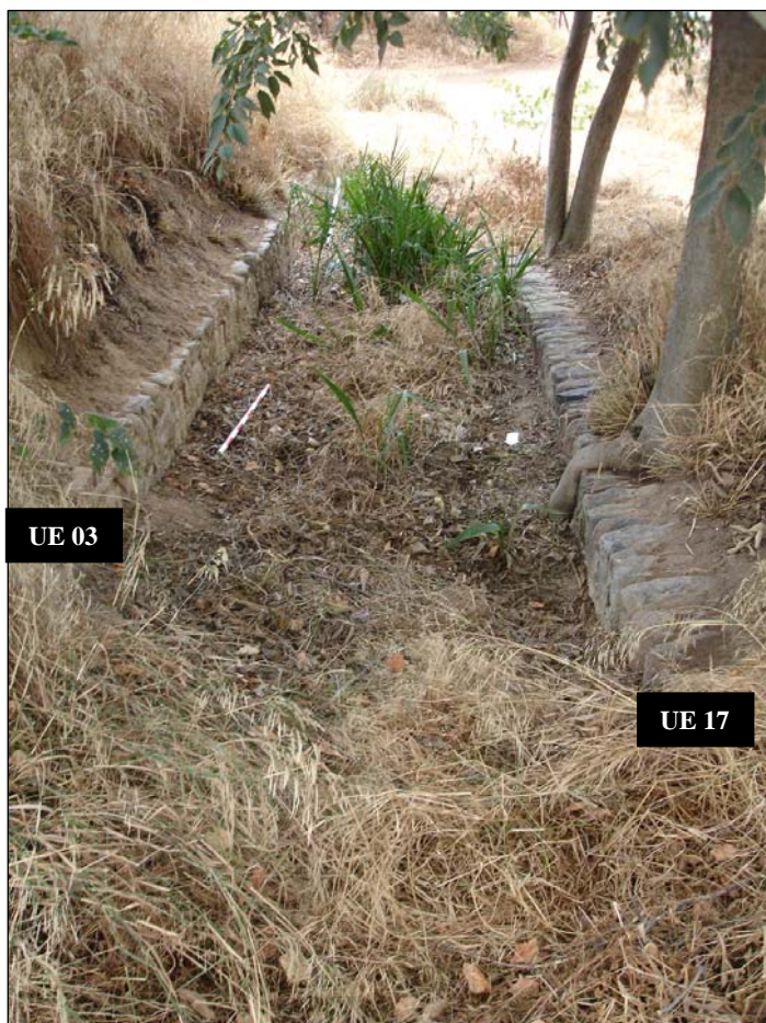
Foto 22. Neteja de la continuació de la UA 22 al sud de la intervenció, vista des del nord.
