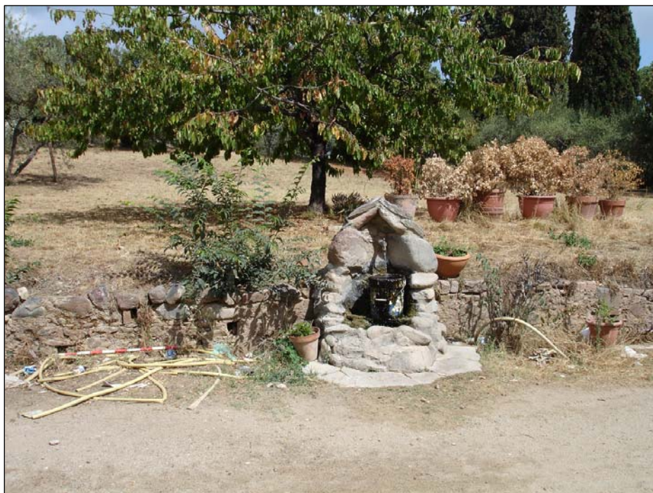
Foto 24. Detall de la font adossada al mur UE 03, davant la façana de la masia de can Terrers. Al mur UE 03 es poden apreciar alguns dels forats de drenatge rematats amb totxo massís, a diferents alçades.
