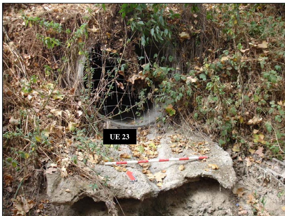
Foto 6. Desguàs del col·lector UE 23 al torrent de Malhivern.
