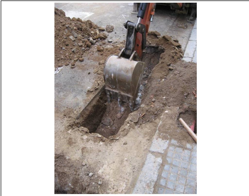
Foto 11: Procés de desmuntatge de les estructures- W.
