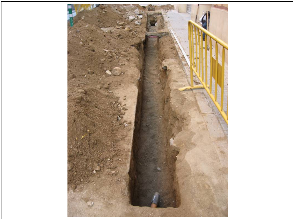
Foto 12: Foto final de la rasa.
