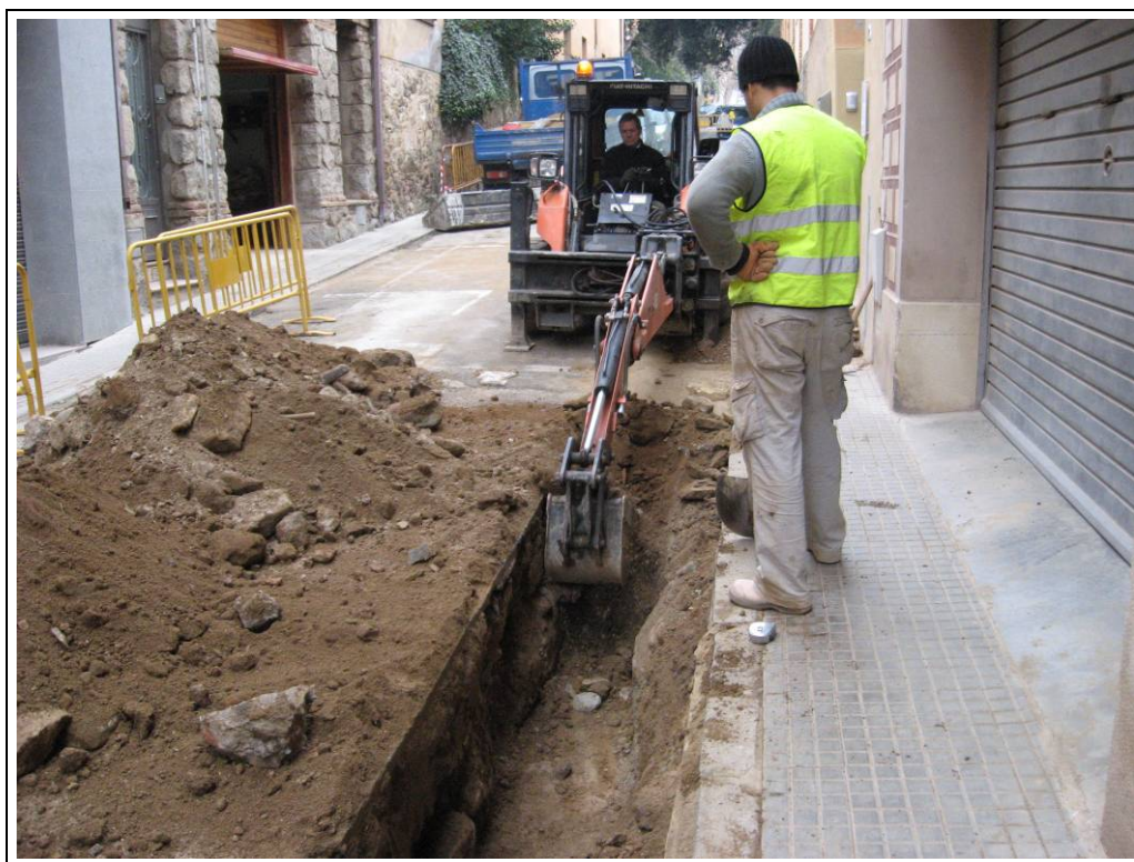
Foto 10: Procés de desmuntatge de les estructures- W.
