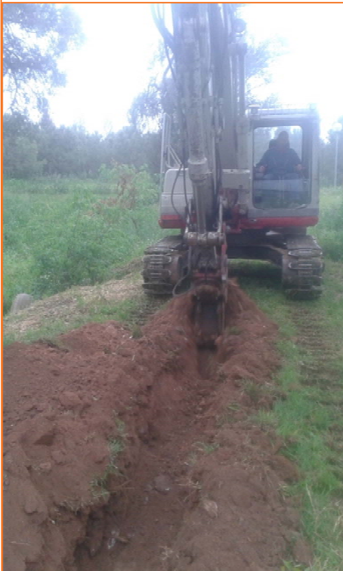
Foto 2. Vista de detall del rebaix de la rasa.
