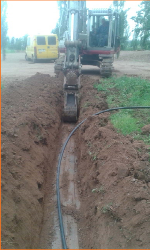
Foto 7. Vista del rebaix de la rasa.
