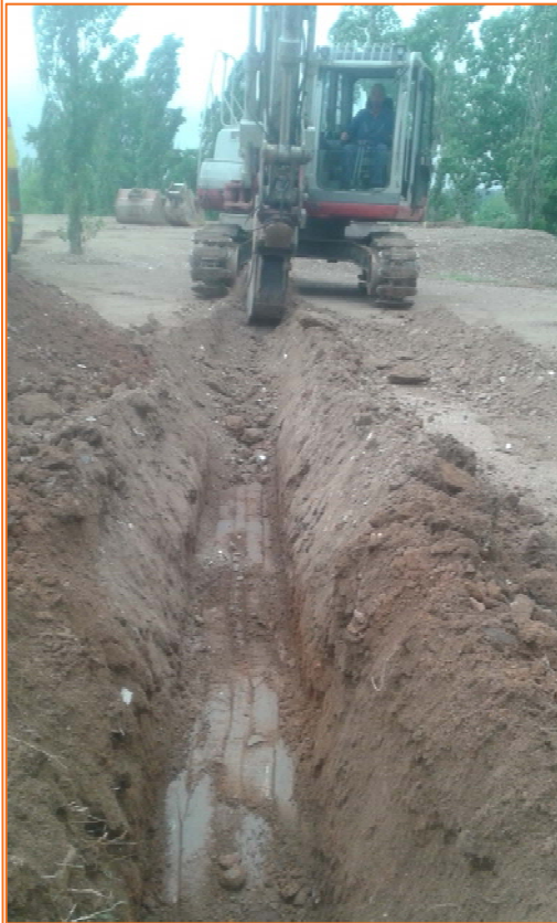
Foto 8. Vista del rebaix de la rasa.
