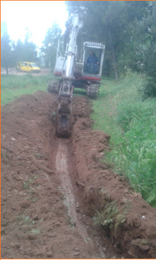
Foto 5. Vista del rebaix de la rasa.
