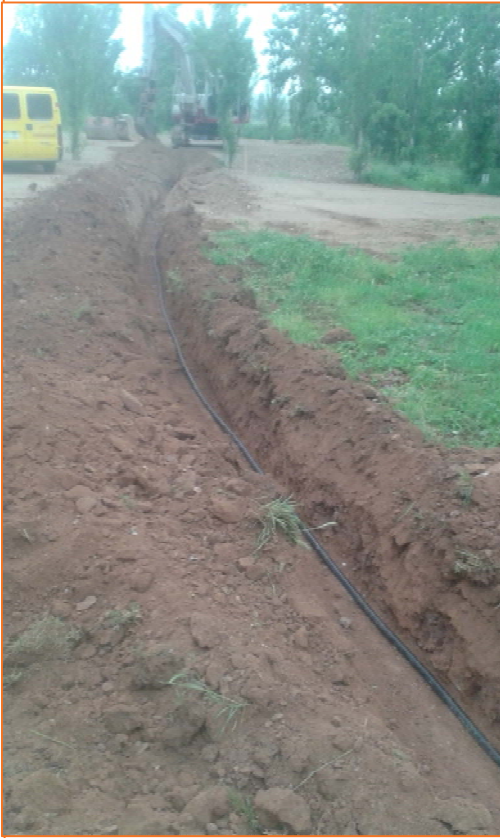
Foto 9. Vista general del final d'un tram de la rasa.
