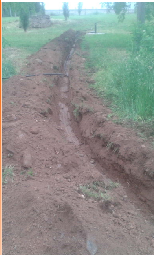
Foto 4. Vista general del final d'un tram de la rasa.
