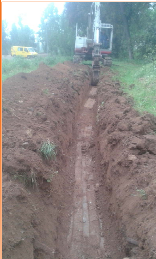
Foto 6. Vista del rebaix de la rasa.
