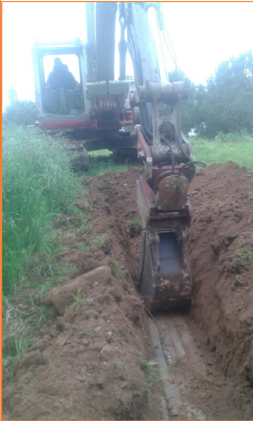
Foto 3. Vista de detall del rebaix de la rasa.
