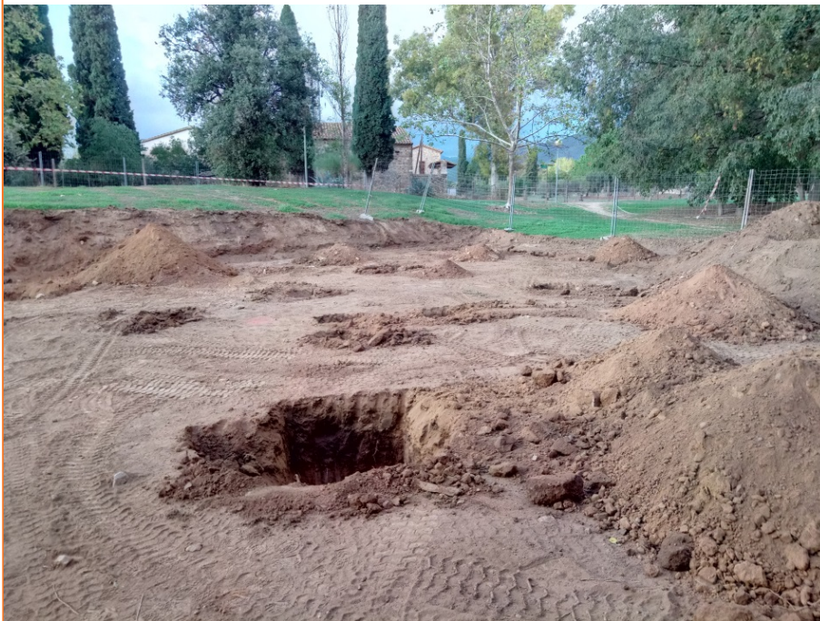
Foto 10. Fotografia final un cop realitzats els treballs.
