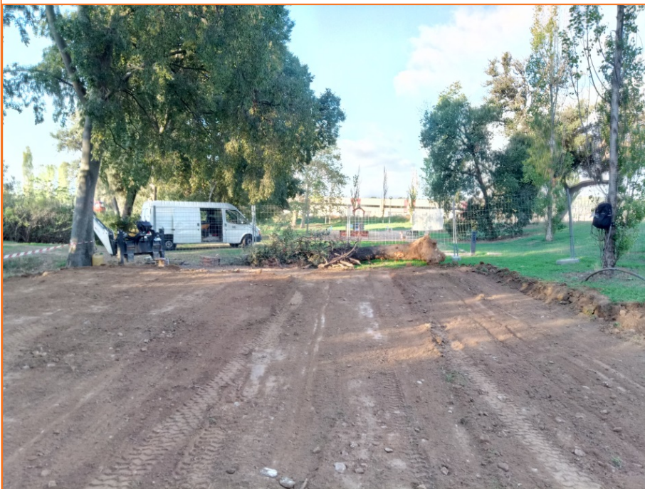
Foto 4. Fotografia un cop realitzats els treballs dels rebaixos.
