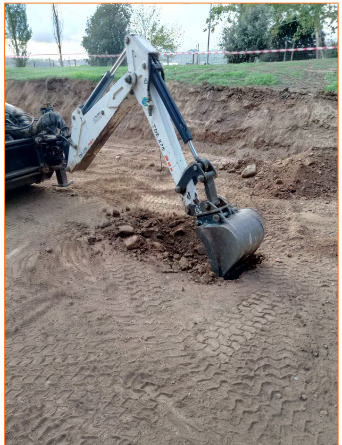
Foto 6. Treballs d'obertures per a la col·locació de fonamentacions.
