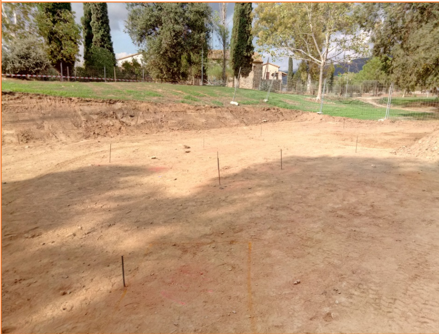
Foto 5. Situació dels forats de fonamentació al solar.
