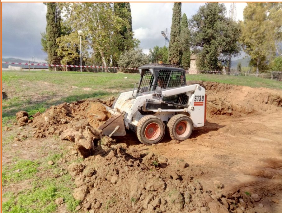
Foto 2. Desenvolupament dels treballs dels rebaixos.
