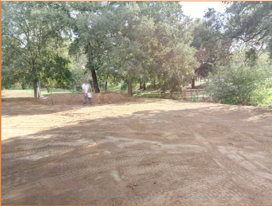
Foto 3. Fotografia un cop realitzats els treballs dels rebaixos.
