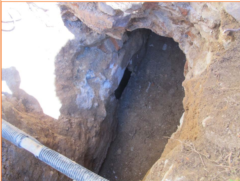
Foto 2. Vista de detall amb la mina on s'ha de fer la connexió amb el tub existent del desguàs.
