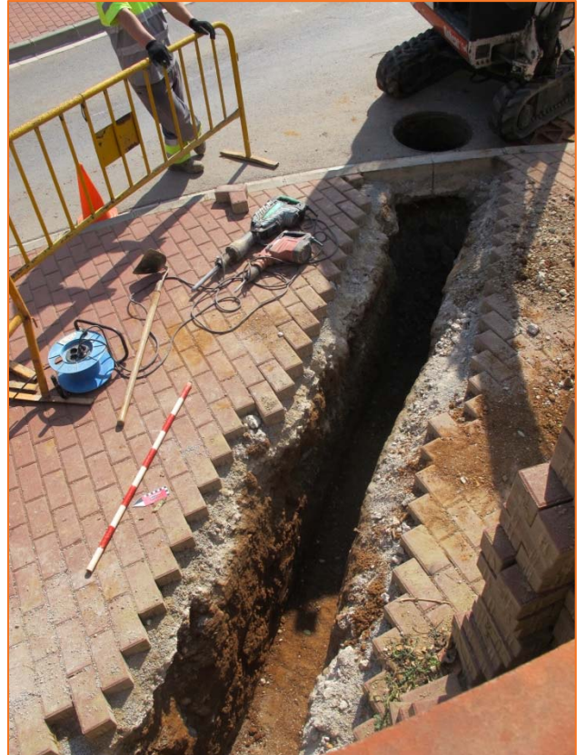
Foto 12. Imatge final de la rasa ja tota oberta.
