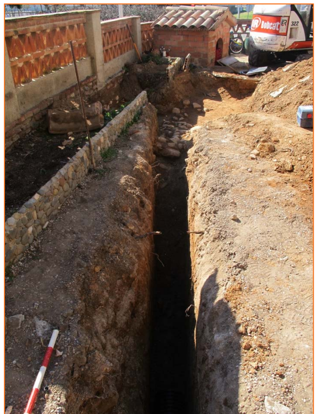
Foto 8. Vista de la rasa amb el paviment UE 7 al fons.
