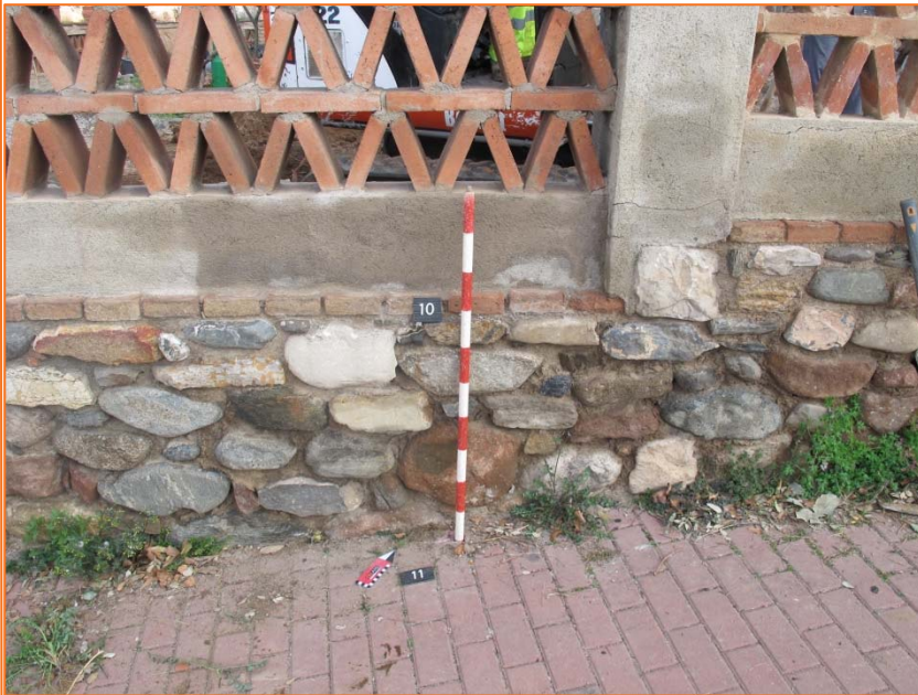
Foto 9. Mur UE 10 i paviment de la vorera UE 11.
